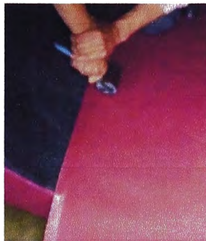
Figura N° 3.10. Ruleteo de plancha de caucho sobre las superficies metálicas.
