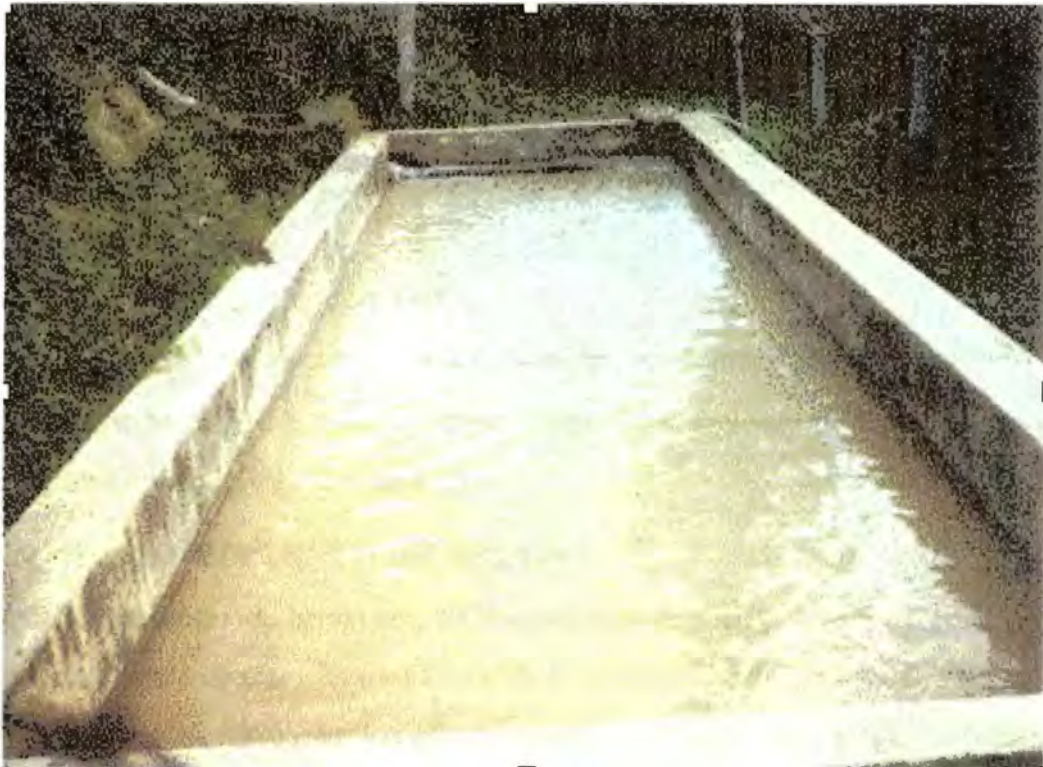
Foto2 Sedimentador convencional de forma rectangular y flujo horizontal en una zona rural
