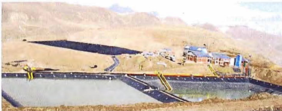
Figura II-8. VAT LEACHING, para leyes mayores a 5 g/TM [19]
