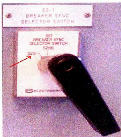
Fig. 3.20 Selección del breaker (lados 16.5kV ó 220kV)
