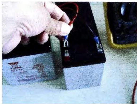
Figura 4.5. Conectar las baterías alimentando al TRE
