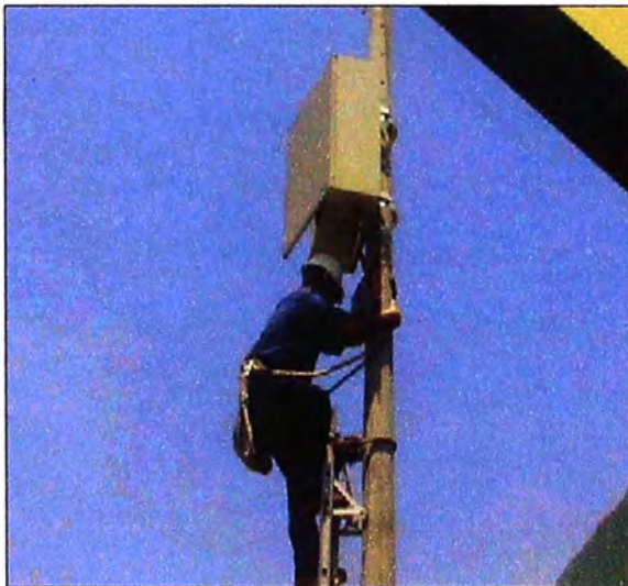
EN SERVICIO EL BANCO DE CONDENSADORES CON EL PERSONAL DE EDELNOR Y
