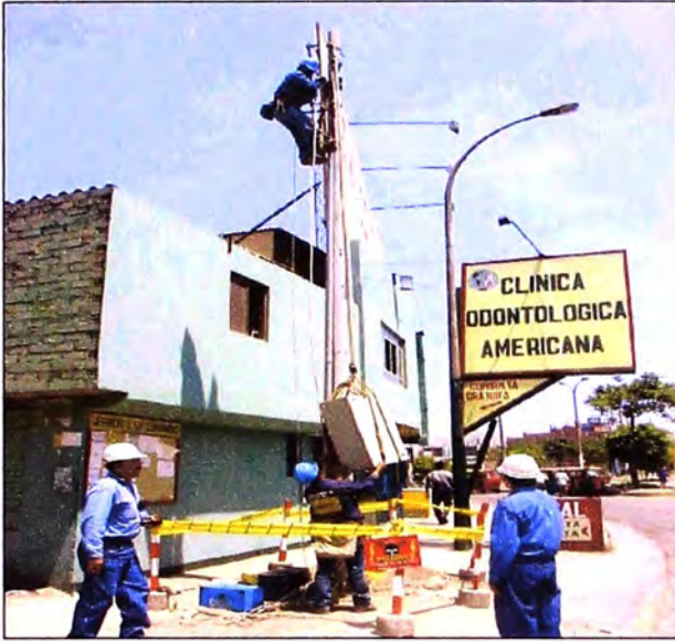
CONEXIÓN DEL BANCO A LA RED DE BAJA TENSION
