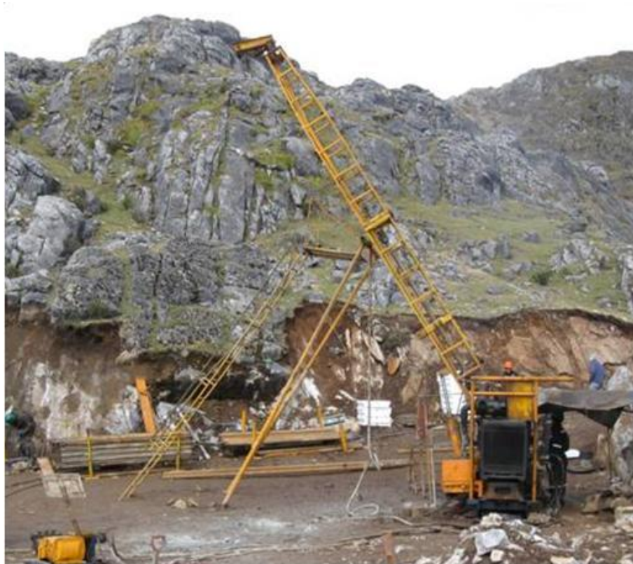
Figura 3.6. Instalación de una plataforma, máquina LM-75
