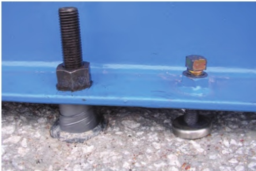
Figura N° 5.22.- Sujeción de la bomba con su respectiva base
