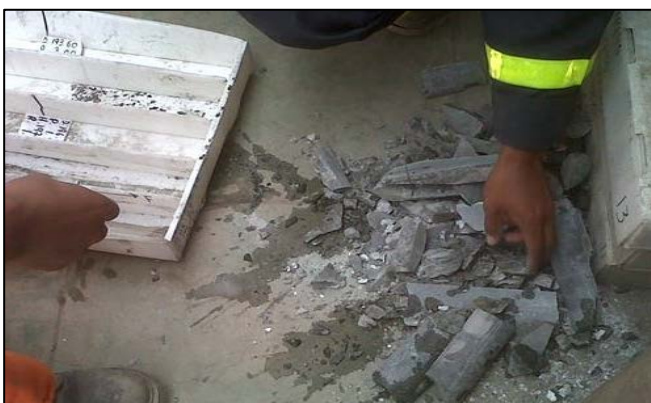
Figura 3.4: Caída de caja, práctica inadecuada.
