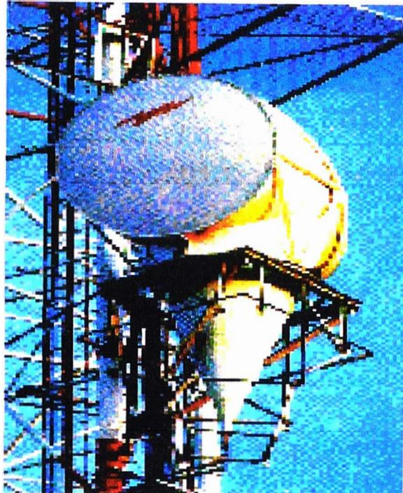
*Figura 2.22 Sistema de Antena LMDS*
