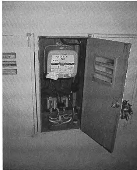
**Fig. 3.19** Inyección de Señal BPL en Banco de Medidores BT
