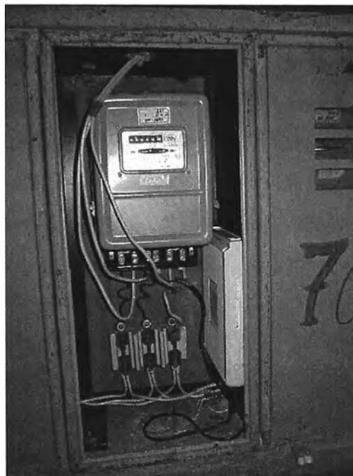
**Fig. 3.17** Repetidor BT TDD en caja de medidor
