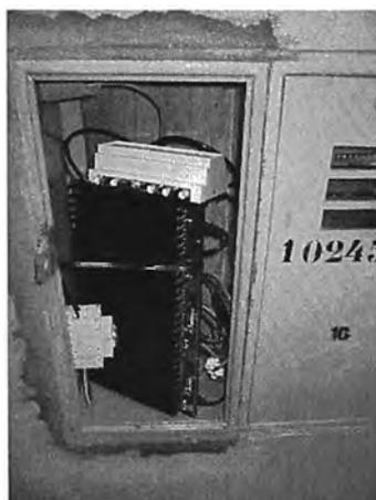
**Fig. 5.13** Caja de Medidor con Equipo BPL
