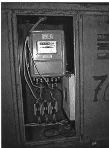
**Fig. 5.14** Caja de Medidor con Medidor Eléctrico y Equipo BPL
