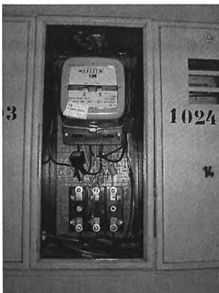
**Fig. 5.15** Caja de Medidor de Cliente con Filtro y Acoplador Inductivo
