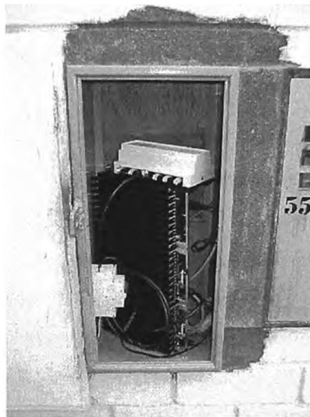
**Fig. 3.16** Repetidor BT FDD en caja de medidor
