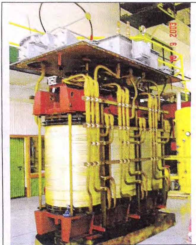
Fig. 6.9 – Desmontaje del transformador
