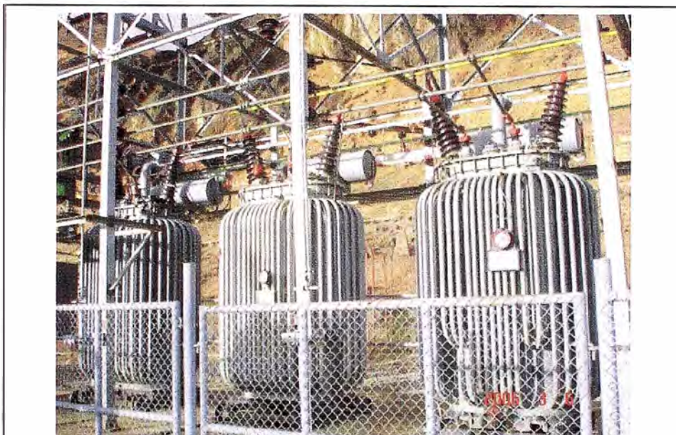
Fig. 6.15 – Foto del transformador de la Subestación San Cristobal que fue desmontado para la inspección correspondiente.
