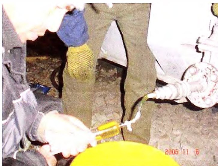
Fig. 2.2 – Obtención de muestra de aceite
