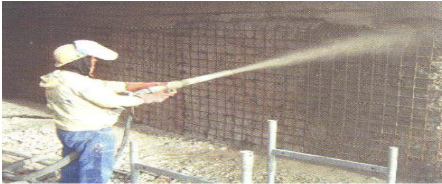
FIGURA 10: Personal lanzando shotcrete – fuente archivo SIMSA.
