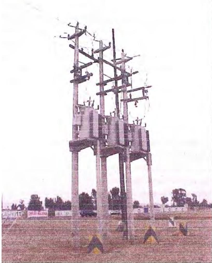
**Figura N° 4.1 :** Banco Regulador de Tensión instalado en el circuito S-05
