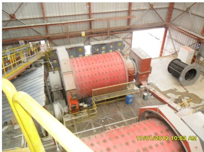
Figura 13: Vista panorámica de la nave de molienda primaria.
