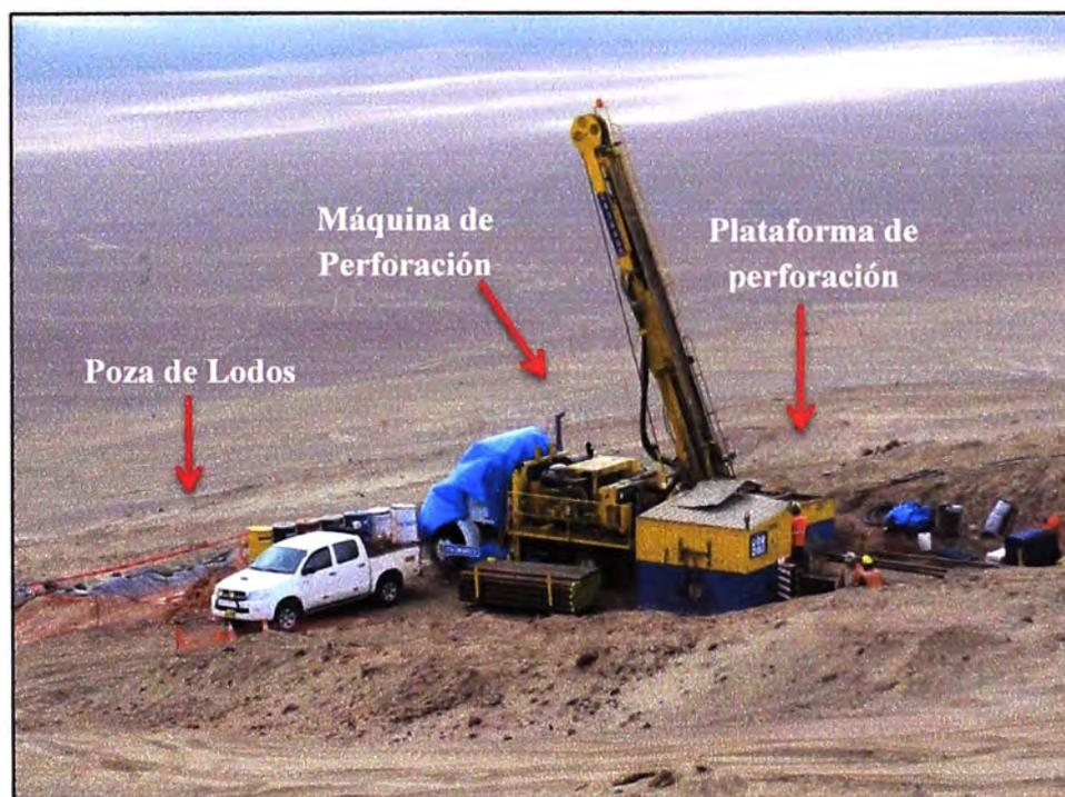
**Figura 8.3** Preparación de plataforma.
