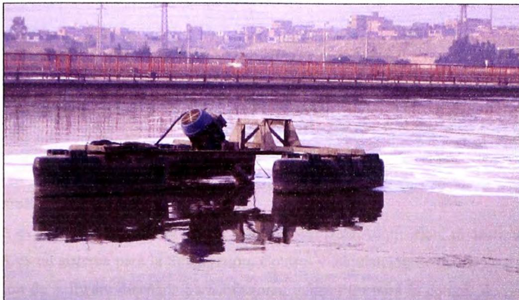
Figura 1.2 Laguna de aguas residuales con aireación artificial
