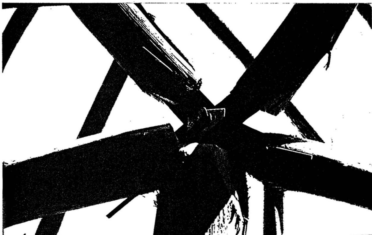
Otra ha sido diseñada como techo para las aulas de las escuelas. Consiste en un entramado espacial de elementos de madera de pequeña sección (3x3 cm) con cubierta de carrizo. Puede cubrir áreas hasta de 7.20x7.20 m sin apoyos intermedios.
