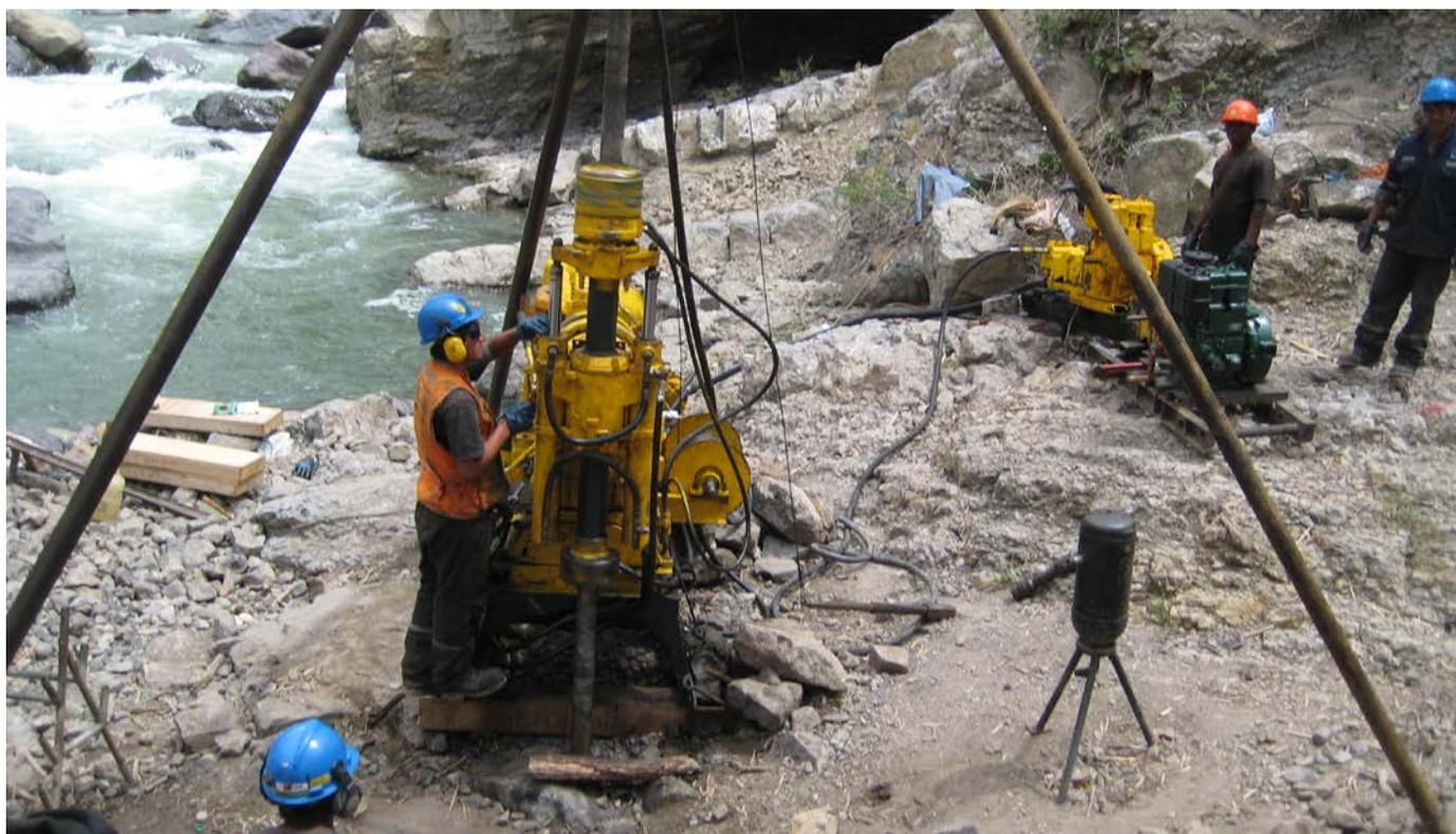
**Foto N° 5.2 Equipo de perforación: Máquina de Perforación, bomba y tubo de perforación HQ (7.6 cm de diámetro)**
