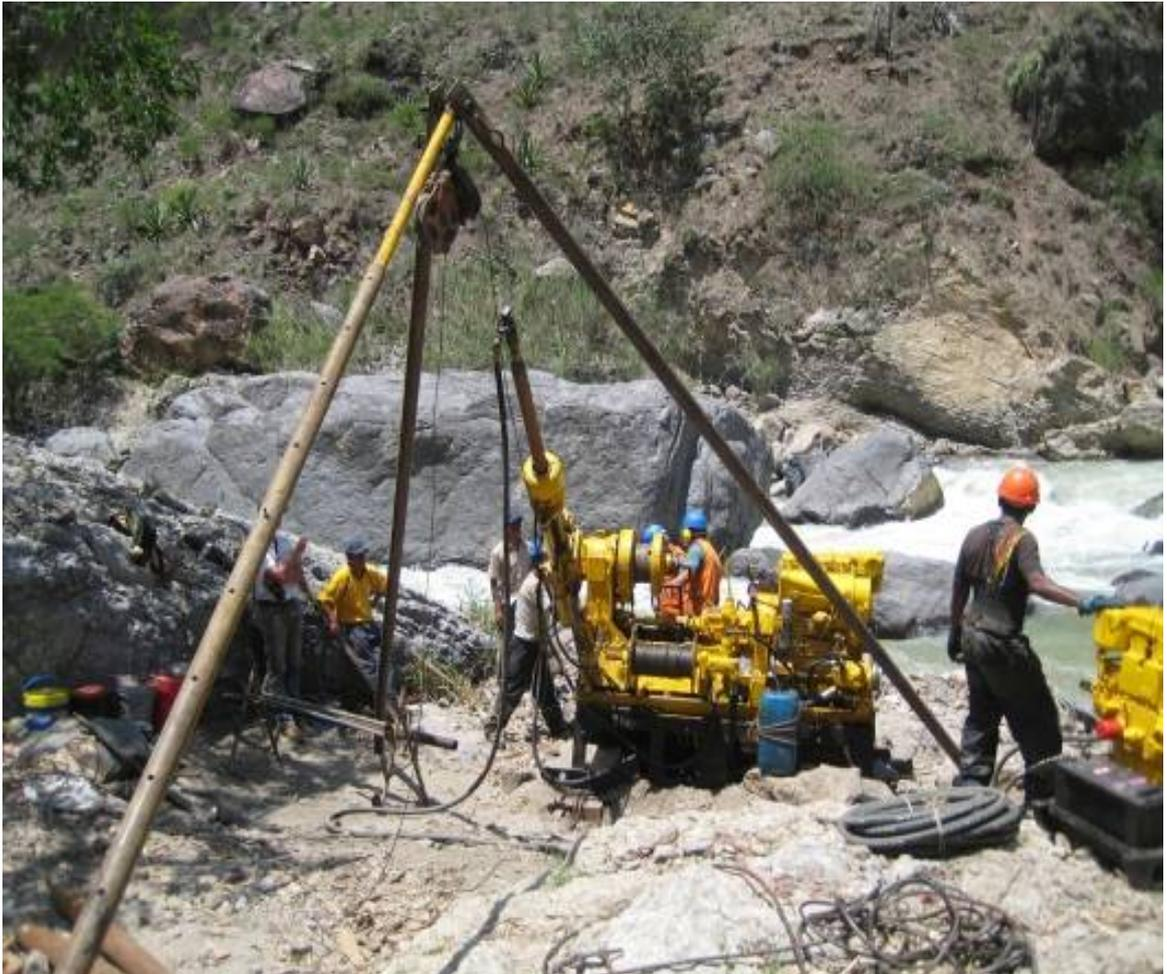
**Foto N° 10.1 Equipo de Perforación Lonyer 38 realizando un Sondeo Inclinado (Eje de Presa)**
