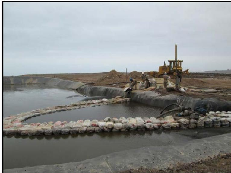
**Figura 6.5:** Formación del espejo de agua y bombeo de la solución barren
