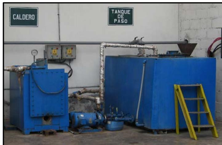
**Figura 5.17:** Caldero y el tanque de paso
