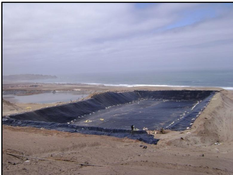
**Figura 8.5:** Instalación de la geomembrana HDPE en la relavera N° 2
