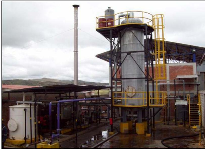
**Figura N° 2.6** Reactor de Desorción
