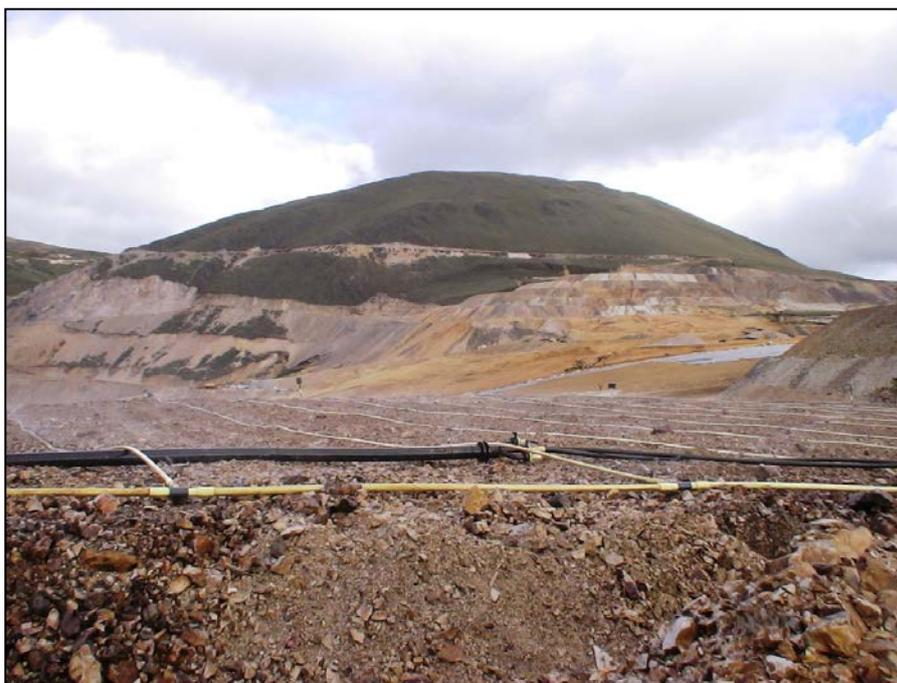
**Figura N°3.2** Lixiviación del Mineral del Tajo SuroNorte
