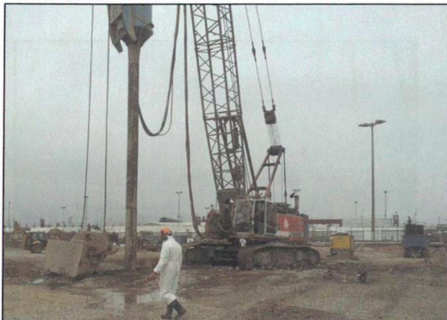
Foto N°02: Equipo de vibración y compactación para las columnas de grava.
