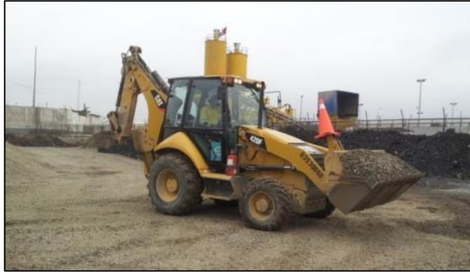
**Figura N°5.6: Acarreo del material de grava hacia la tolva.**
