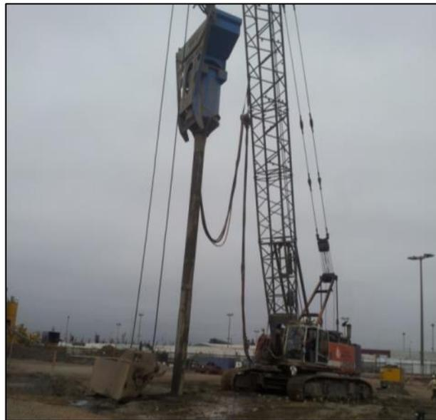
**Figura N°5.5: Posicionamiento e hincada del vibrador sobre los puntos de las columnas de grava.**
