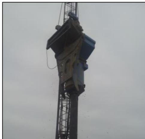
**Figura N°5.8: Vertido de grava de la tolva al tubo alimentador.**
