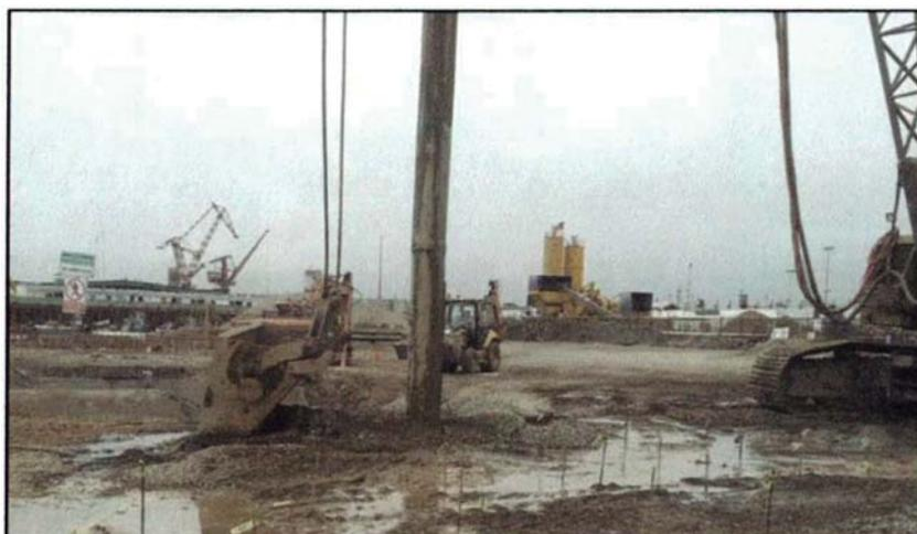
Foto N°04: Posición de máxima perforación para la columna
