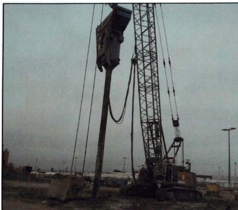
Foto N°03: Posicionamiento del vibrador sobre los puntos de las columnas de grava.
