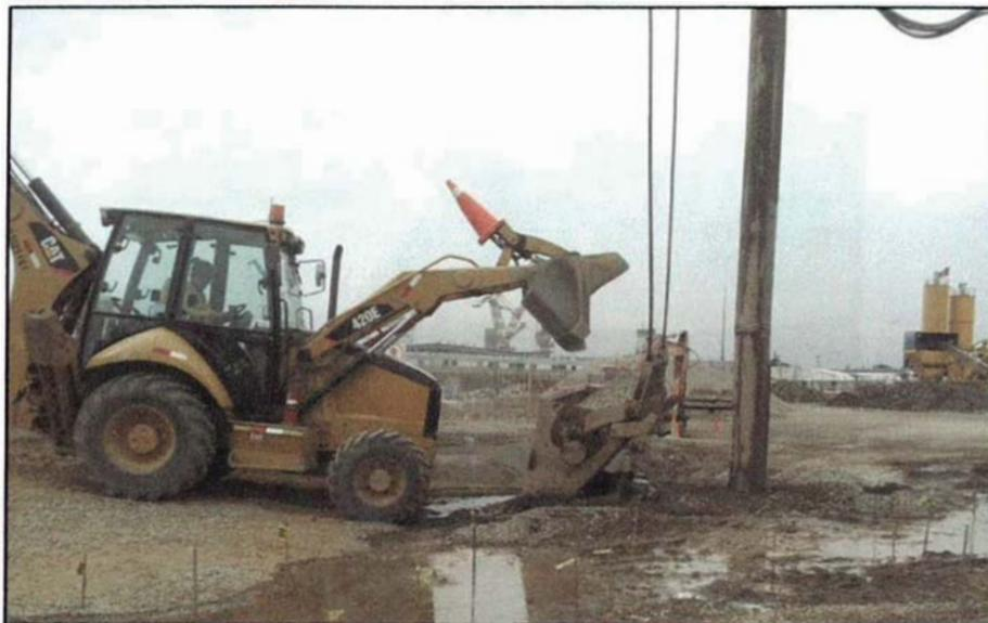
Foto N°06: Vertido del material de grava hacia la tolva del vibrador.
