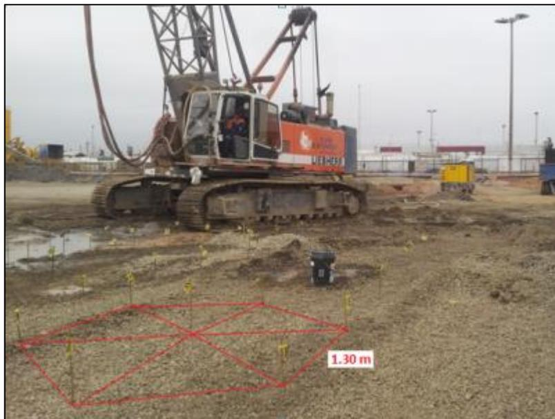
**Figura N°5.1: Puntos topográficos de las columnas, se aprecia que forman triángulos equiláteros de 1.30m de lado.**
