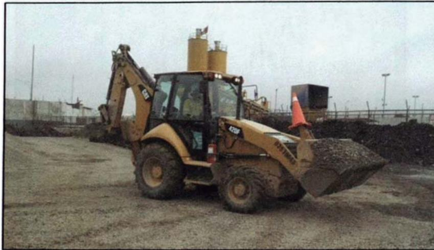
Foto N°05: Acarreo del material de grava hacia la tolva del vibrador.
