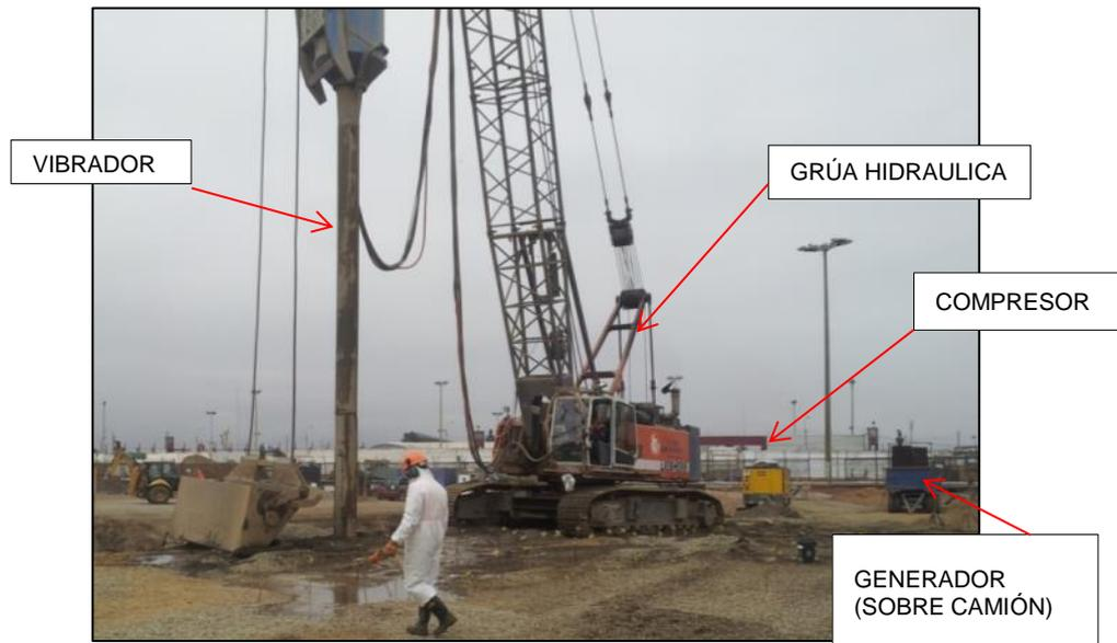
**Figura N°5.3: Equipo de vibración y compactación para las columnas de grava.**
