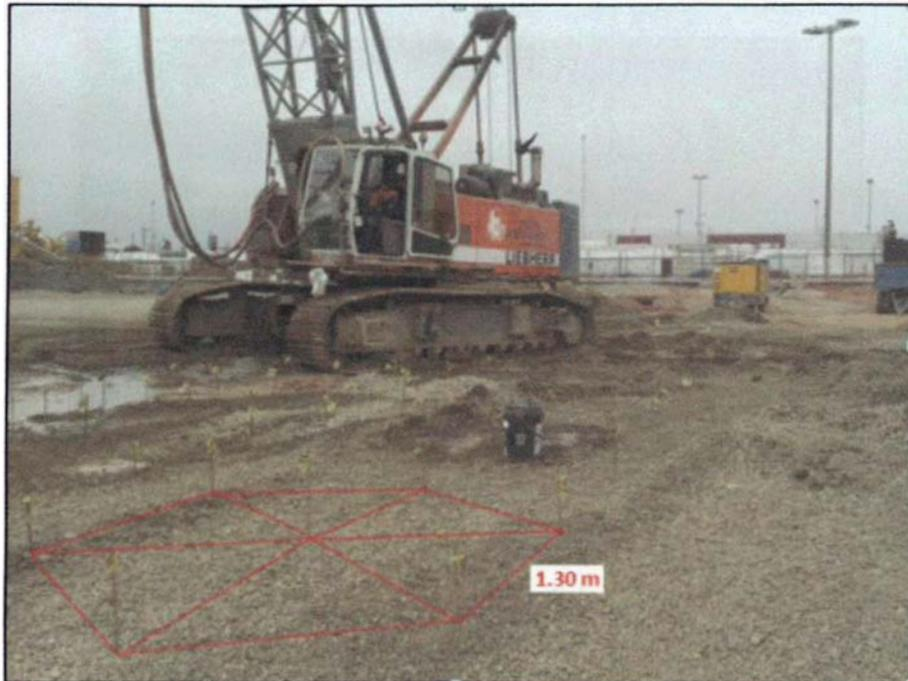
Foto N°01: Puntos topográficos de las columnas, se aprecia que forman triángulos equiláteros de 1.25m de lado.
