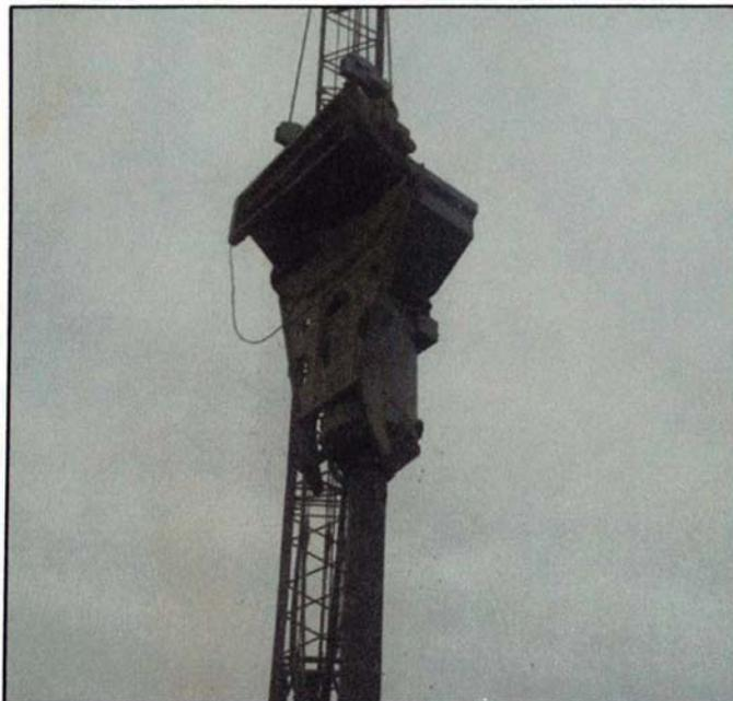
Foto N°08: Vertido del material de la tolva al tubo alimentador.
