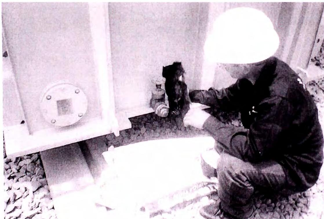
**Foto C2:** El punto de extracción de la muestra se limpia cuidadosamente con trapo.
