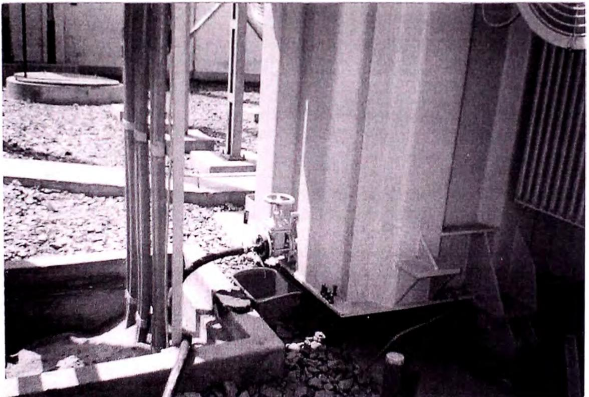
**Foto E6:** Se coloca un recipiente para no ensuciar con aceite las piedras por seguridad del medio ambiente.
