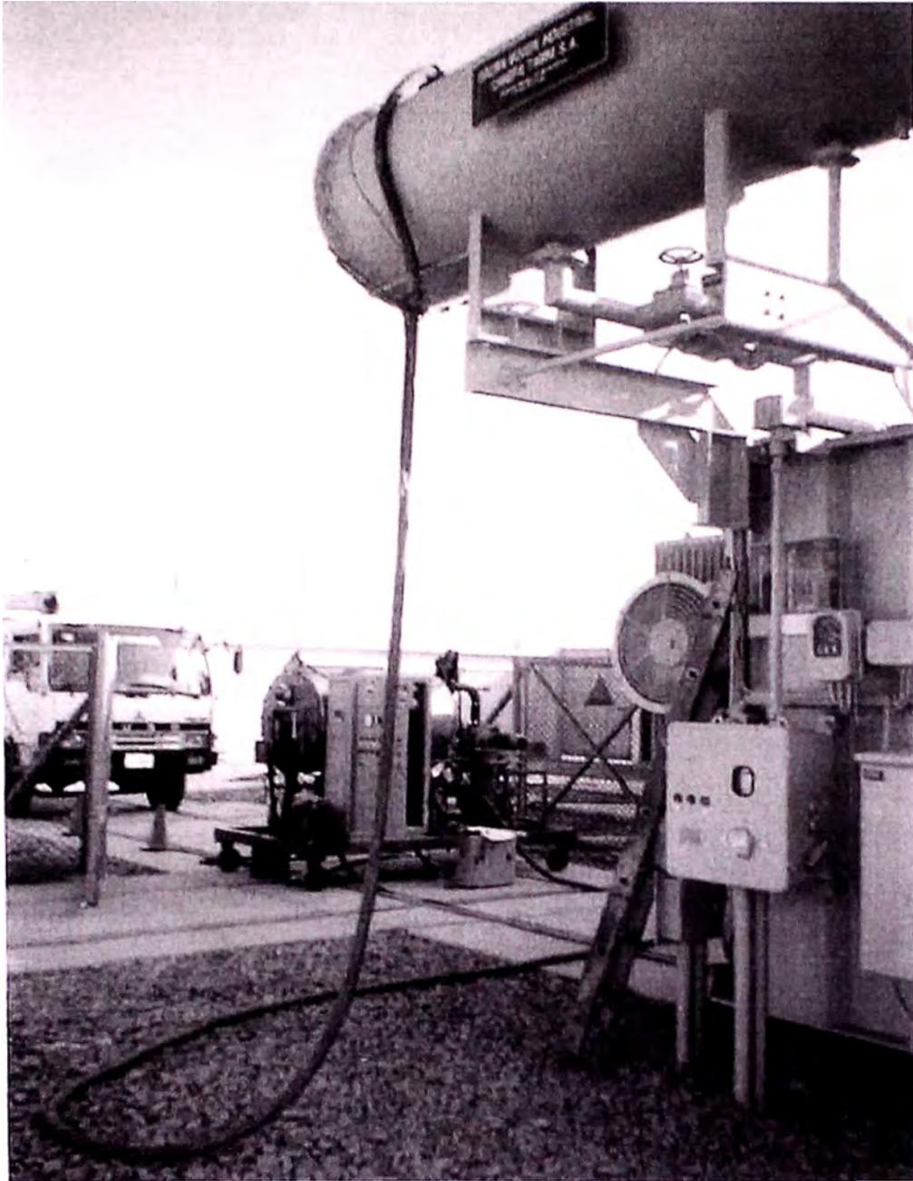
**Foto E8:** Se conecta la manguera de descarga al Tanque Conservador.
