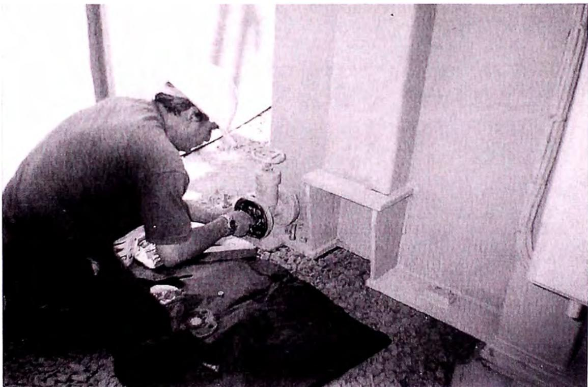
**Foto C5:** Se acopla la brida a la válvula.
