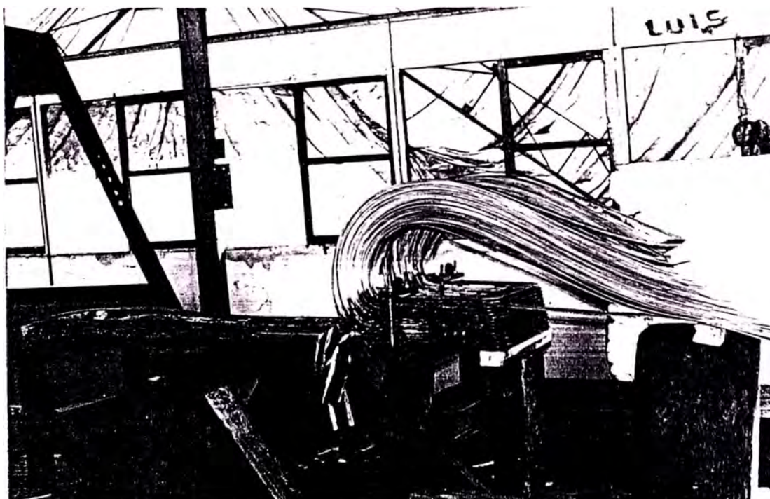
EXTRACCION DEL AISLAMIENTO TIPO "B" Y LIMPIEZA DE LAS ESPIRAS DEL BOBINADO POLAR PARA EL CAMBIO POR EL TIPO "F"
