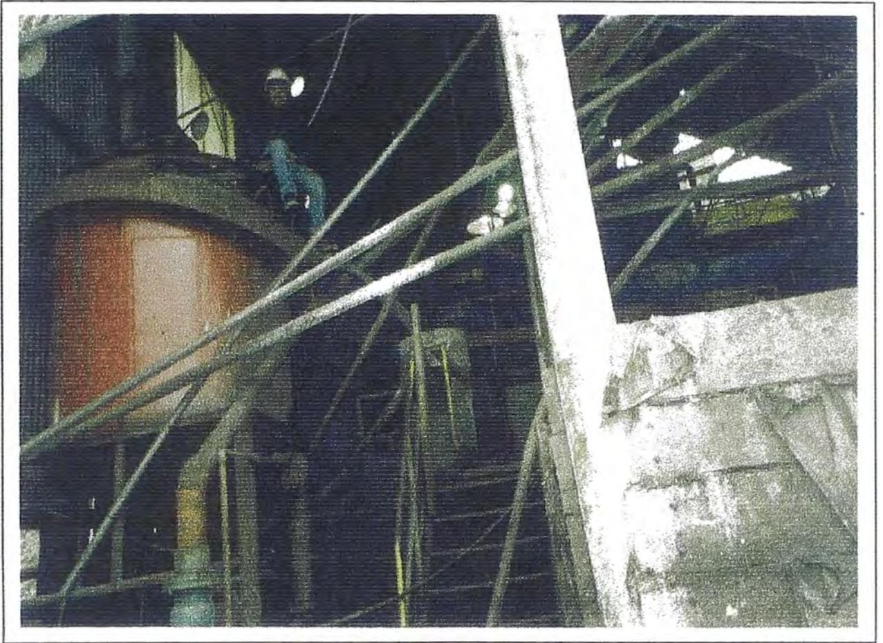
Foto N° 4 Al fondo las celdas del circuito de Pb y más abajo el circuito de Zn. También se observa la Celda Serrano hechiza 6'x 6'.
