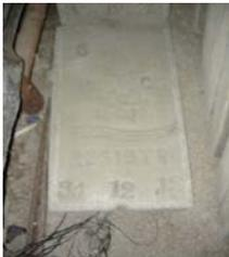
Fabricado en concreto armado con una resistencia de  $f'c=175$  Kg/cm<sup>2</sup>, según la norma NTP 350.085.
