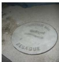
Accesorio de concreto armado, fabricados de acuerdo a la norma NTP 339-111.
