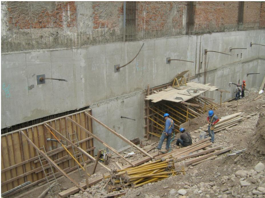
**Fotografía 6.** Construcción de forma alternada de los muros estructurales de los sótanos, dejando una tubería de PVC de 4" para el paso de los cables de acero, en este caso, del anclaje AR-03P<sup>2</sup>, fabricado para ser ensayado al arrancamiento en la obra del Edificio de Oficinas Andrés Reyes, San Isidro - Lima. Cortesía Geotécnica S.A.C.
