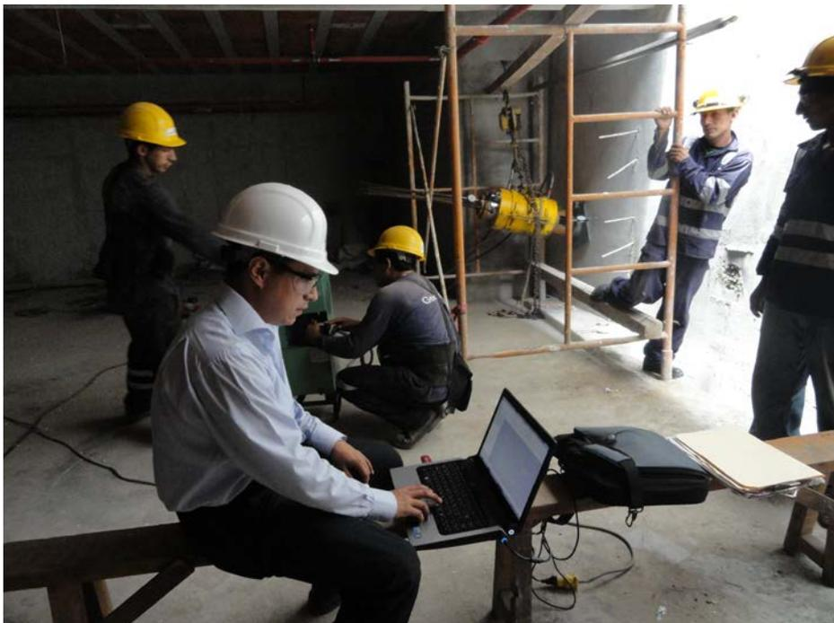
**Fotografía 12.** Ejecución del ensayo de arrancamiento del anclaje postensado de prueba IS-01P, previsto para la obra muros anclados para contención de los taludes resultantes de la excavación para la construcción de sótanos del Edificio del Instituto San Ignacio De Loyola Sede Miraflores - Lima. Cortesía Geotécnica S.A.C.
