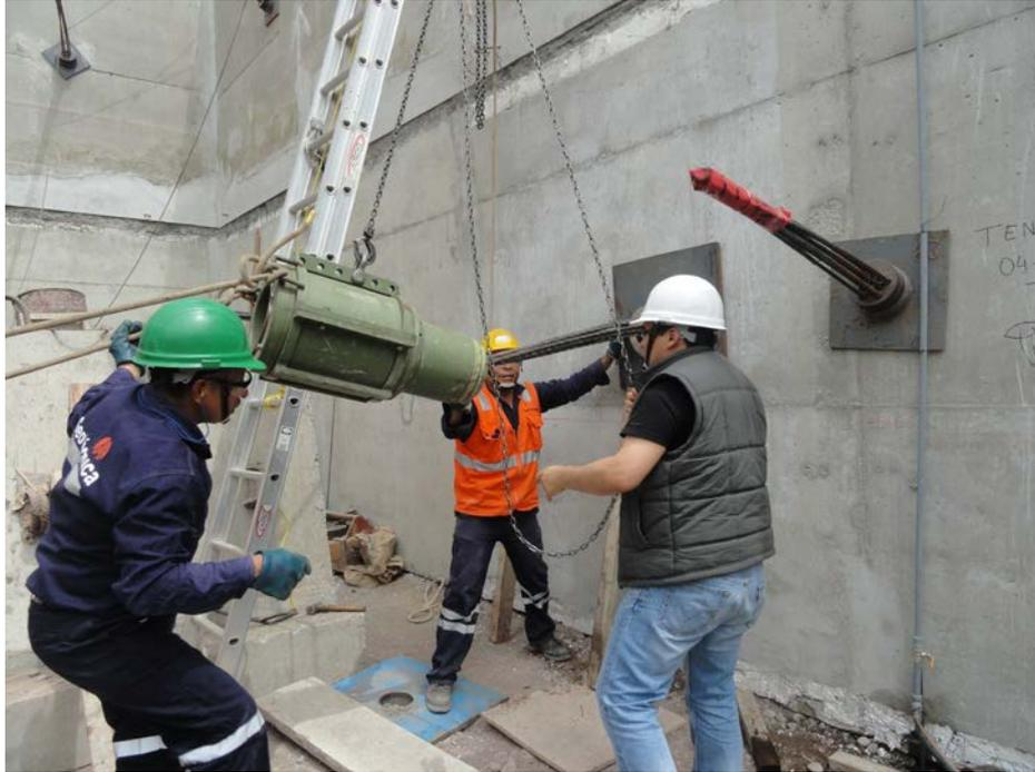
**Fotografía 7.** Izaje del pistón hidráulico Mekano4, para luego de introducir los cables de acero por el cilindro, posicionarlo apoyado sobre el cabezal y placa metálica. Actividad previa al ensayo de arrancamiento del anclaje PL-07P, previsto para la obra del Edificio Centro Empresarial Platino III, Miraflores - Lima. Cortesía Geotécnica S.A.C.
