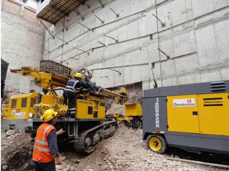
**Fotografía 3.** Perforación del barreno para el anclaje postensado de prueba AR-03P<sup>4</sup>, fabricado para el ensayo de arrancamiento previsto para la obra de muros anclados para contención de los taludes resultantes de la excavación para la construcción de sótanos del Edificio de Oficinas Andrés Reyes, San Isidro - Lima. Cortesía Geotécnica S.A.C.
