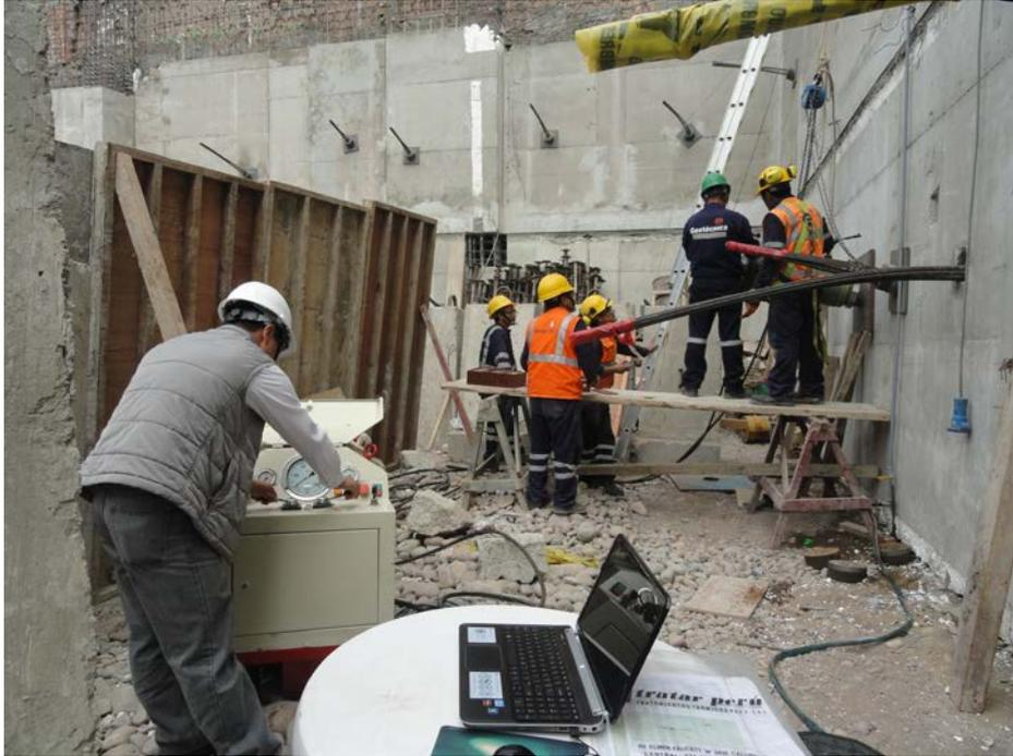
**Fotografía 9.** Aplicación de la carga de alineamiento  $P_a = 0.10P_w$  necesaria para alinear los cables de acero y sujetar el pistón hidráulico Mekano4 para iniciar el ensayo de arrancamiento del anclaje PL-07P, previsto para la obra muros anclados del Edificio Centro Empresarial Platino III, Miraflores - Lima. Cortesía Geotécnica S.A.C.
