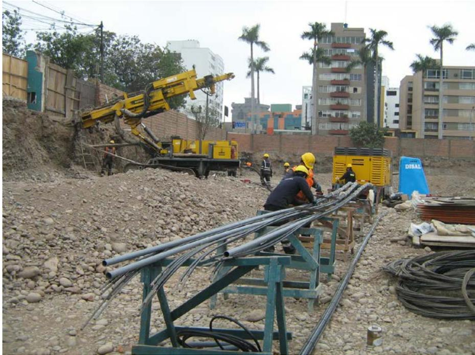
**Fotografía 1.** Montaje del tendón del anclaje postensado JA-02P, fabricado para el ensayo de arrancamiento proyectado en la obra de muros anclados para contención de los taludes resultantes de la excavación para la construcción de sótanos del Edificio de Oficinas Juan de Arona, San Isidro - Lima. Cortesía Geotécnica S.A.C.
