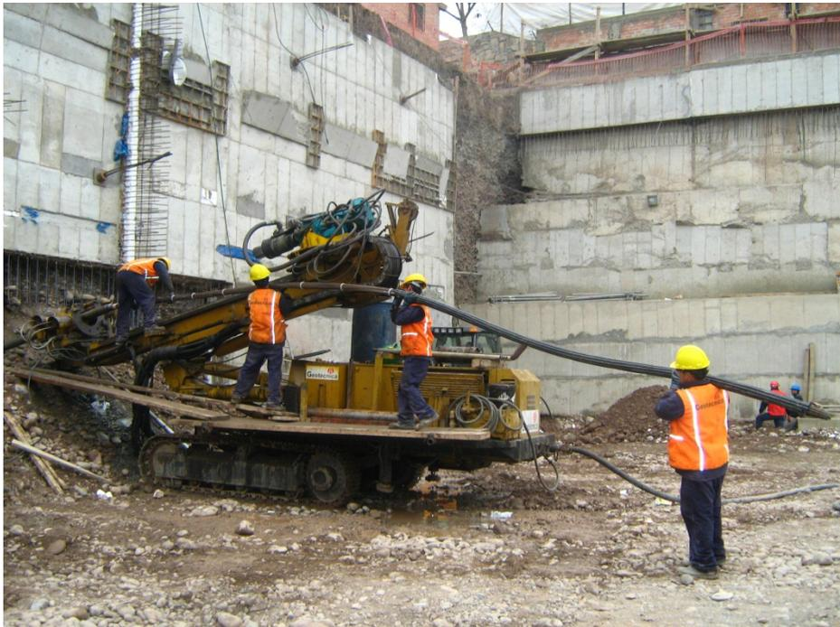
**Fotografía 4.** Instalación del tendón (cables de acero y accesorios) al interior del barreno perforado para el anclaje UL-04P, fabricado para el ensayo de arrancamiento proyectado en la obra de muros anclados del Edificio de Aulas de la Universidad de Lima, Santiago de Surco - Lima. Cortesía Geotécnica S.A.C.
