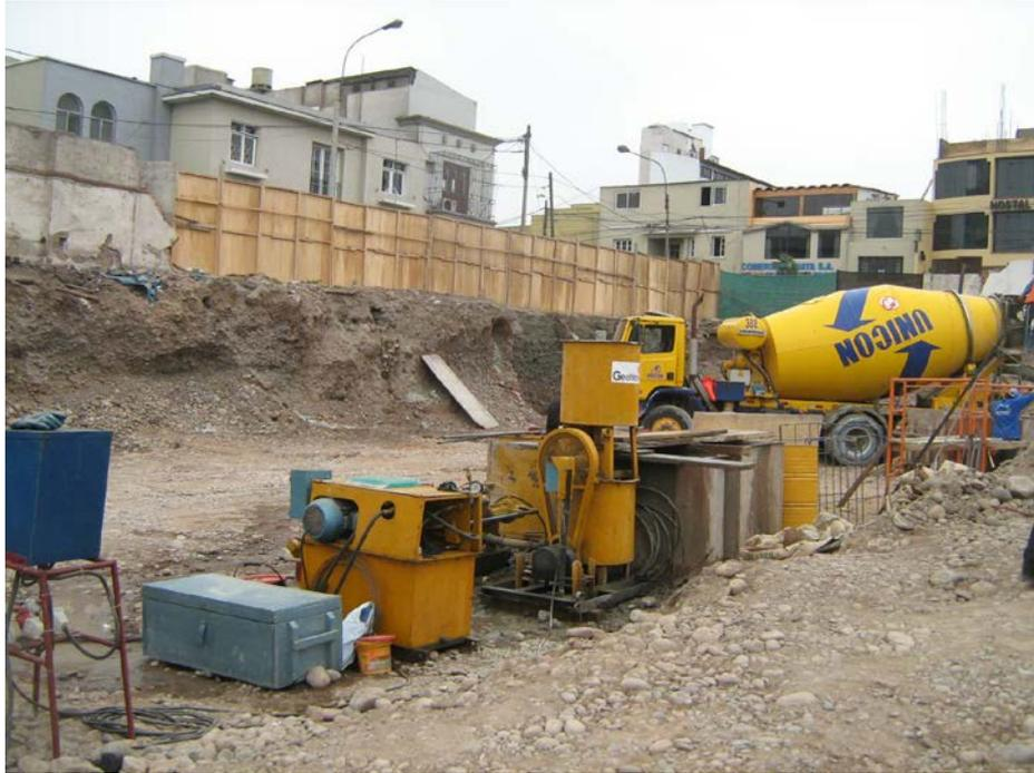
**Fotografía 5.** Disposición de los equipos de inyección de lechada de cemento para formación del bulbo del anclaje postensado JA-02P, fabricado para el ensayo de arrancamiento previsto para la obra de muros anclados del Edificio de Oficinas Juan de Arona, San Isidro - Lima. Cortesía Geotécnica S.A.C.
