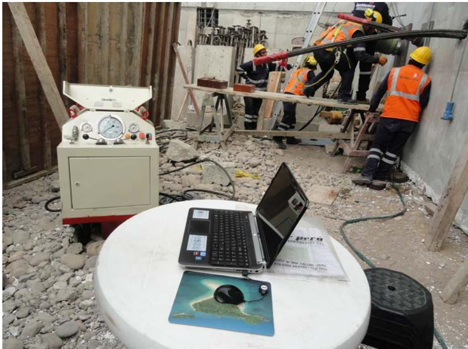
**Fotografía 8.** Disposición de los equipos necesarios para el ensayo de arrancamiento, a la izquierda de la fotografía se aprecia la bomba hidráulica para el accionamiento del pistón hidráulico Mekano4. Ensayo del anclaje PL-07P, previsto para la obra del Edificio Centro Empresarial Platino III, Miraflores - Lima. Cortesía Geotécnica S.A.C.
