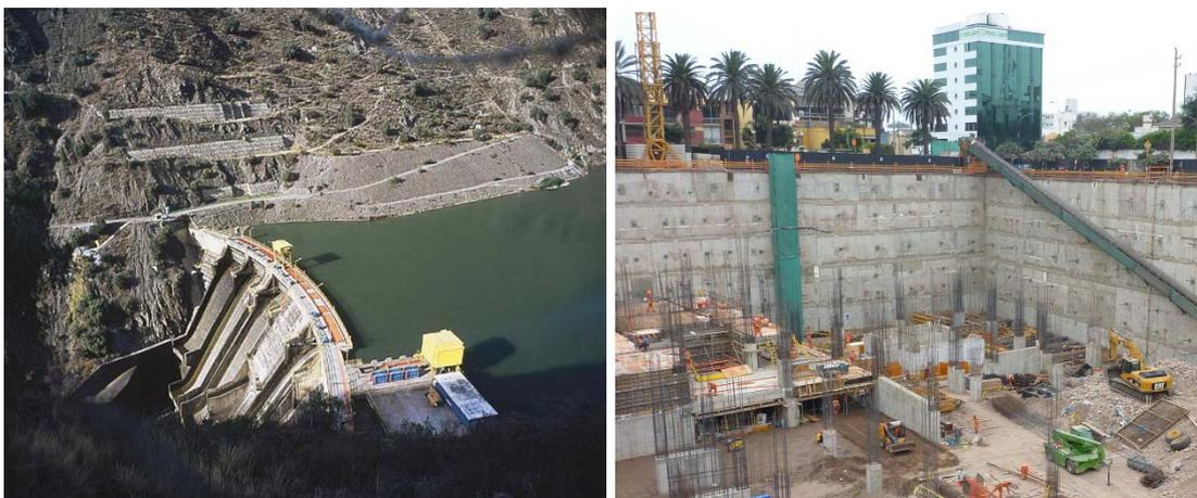
**Fig. 3.1.** A la izquierda, estabilización de los taludes laterales del vaso de la Presa Tablachaca, Derrumbe N° 05, Huancavelica, Perú - 1982. A la derecha, muros anclados conteniendo los taludes resultantes de la excavación de los sótanos del Edificio de la Clínica Delgado, Miraflores - Lima, Perú - 2011. Cortesía Geotécnica S.A.C.
