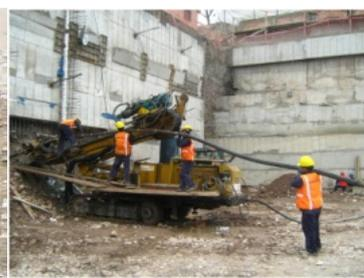
**Fig. 2.7.** Preparación de anclajes en la obra Casino Atlantic City, Miraflores - Lima. Cortesía Geotécnica S.A.C. **Fig. 2.8.** Perforación e instalación de anclajes en la obra del Edificio de Aulas y Sótano de la Universidad de Lima, Santiago de Surco - Lima. Cortesía Geotécnica S.A.C.
