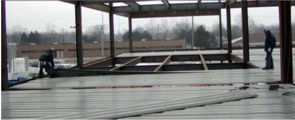
Figura N° 2.10 Colocación de planchas metálicas en el sistema deck.
