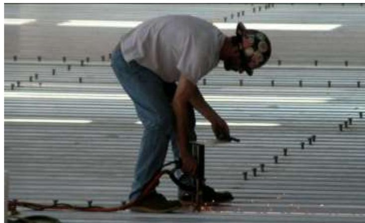
Figura N° 2.13 Puesta de conectores de corte.
