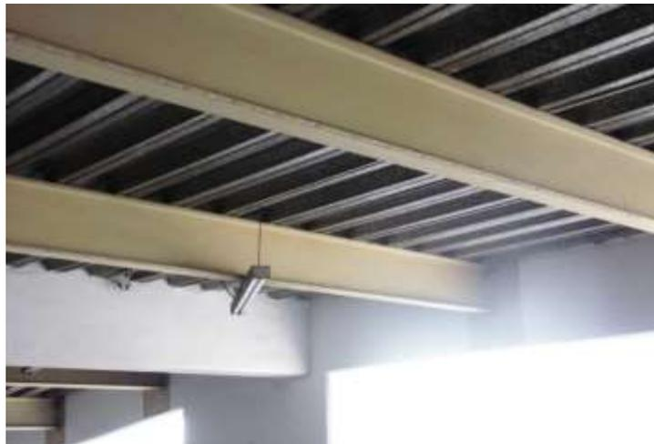
Figura N° 2.1 Viga de sección compuesta en área de estacionamiento del centro comercial “Tottus” de Atocongo.
