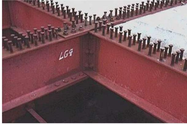
Figura N° 1.10 Viga de sección compuesta con conectores de cortes.
