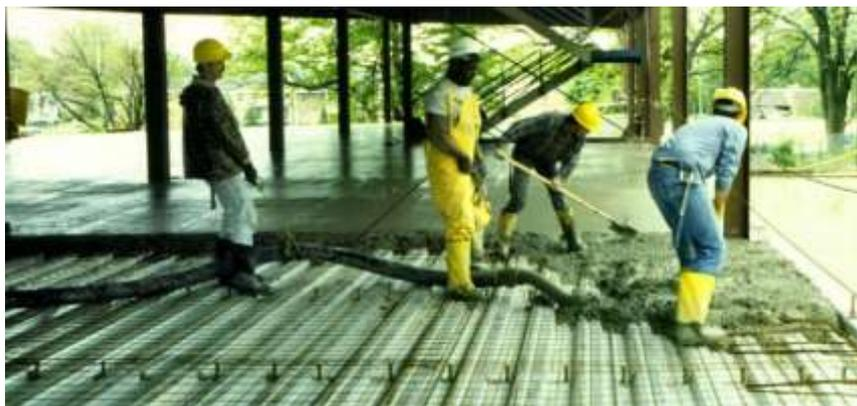
Figura N° 2.15 Vaciado del concreto.
