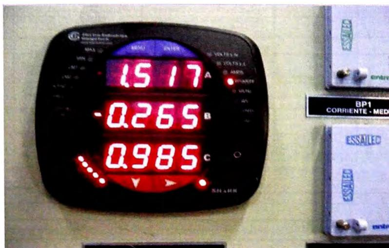
**Figura 6.7.** Inspección visual de la potencia generada del grupo generador en el HMI.
