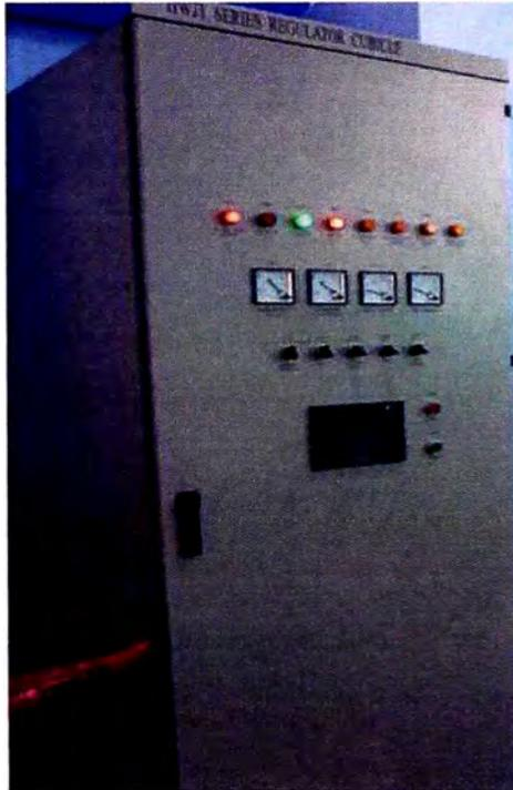
**Figura 3.2.** Sistema de regulación de tensión.
