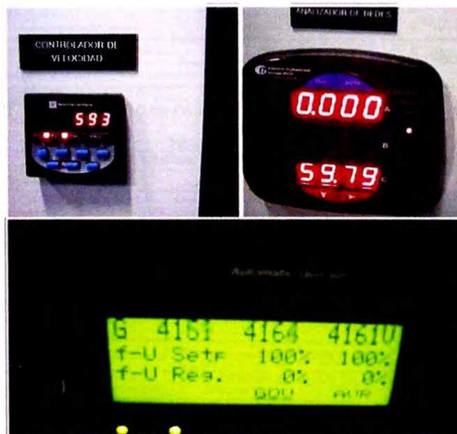
**Figura 6.3.** Inspección visual de los parámetros en el arranque del grupo generador.
