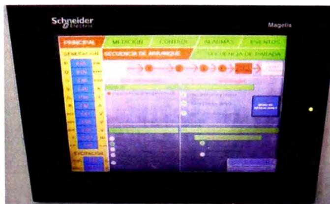
**Figura6.4.** Inspección visual del arranque del grupo generador en el HMI.
