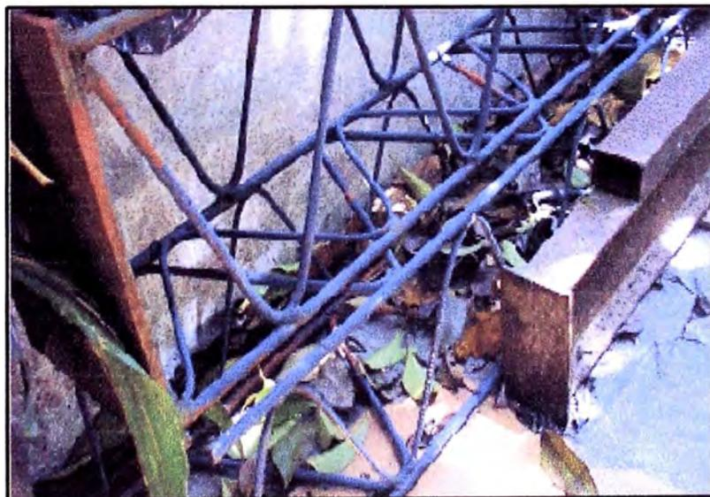
**Fig. 4.5 Estructura Corroída**
