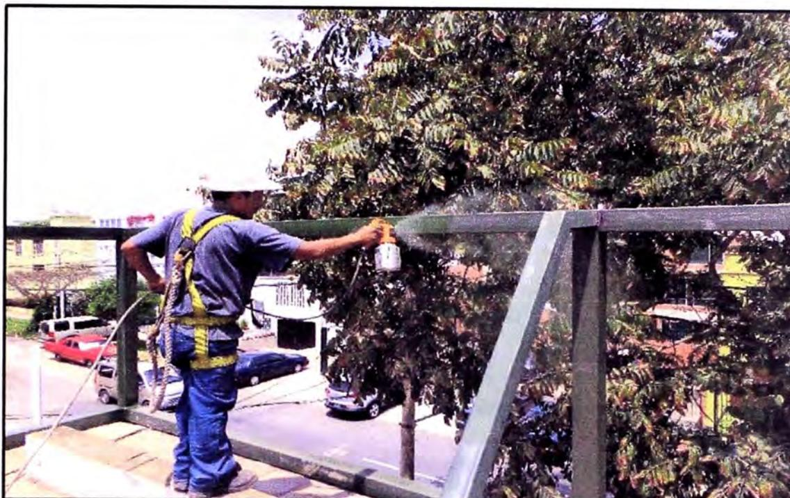
**Fig.3.2** Repase de Pintura base de una estructura para publicidad
