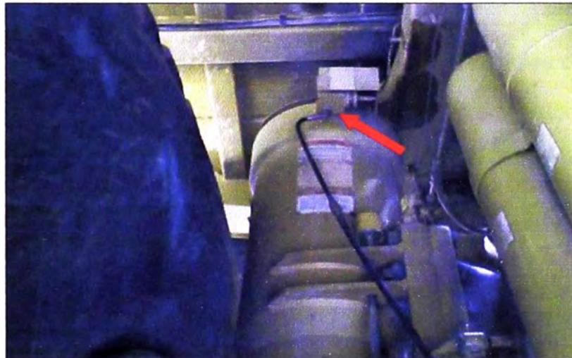
Figura 2.11 Válvula de carga y descarga de nitrógeno
