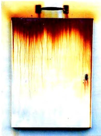
La zona que presenta corrosión es el filo superior de la compuerta, sin embargo una apreciación ligera por un personal no calificado podría indicar un 25% de corrosión.
