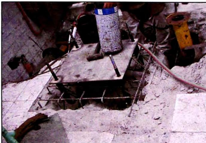
Figura 30 Anclajes de centrifuga
