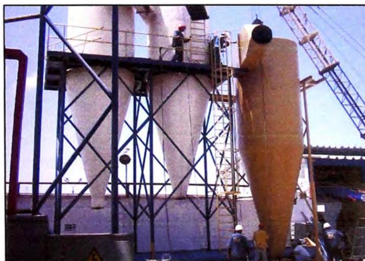
Figura 25 Montaje de ciclón N° 3
