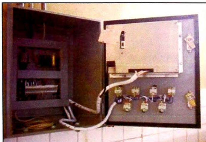
Figura 28 Tablero Electrónico de Balanza
