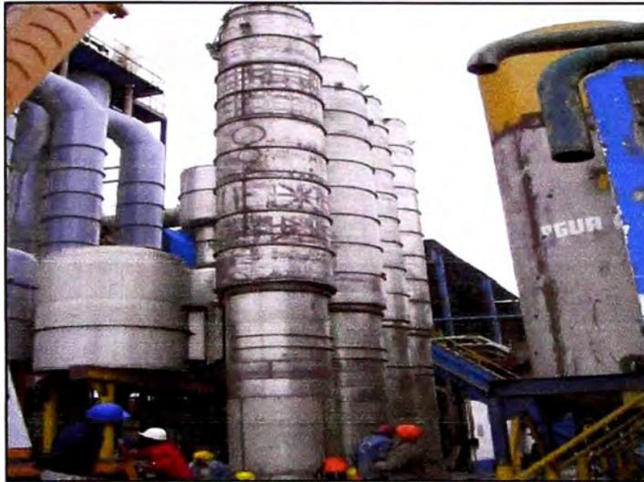
Figura 37 Montaje de efectos
