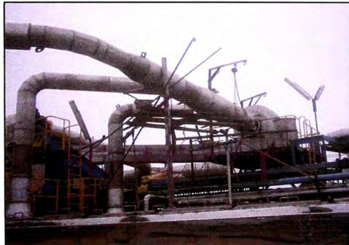
Figura 17 Ducto de vahos de secadores rotadisk
