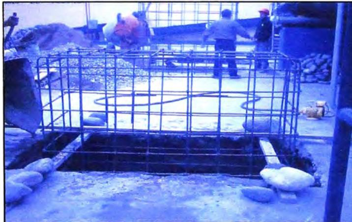
Figura 14 Armazón de base secador Rotadisk
