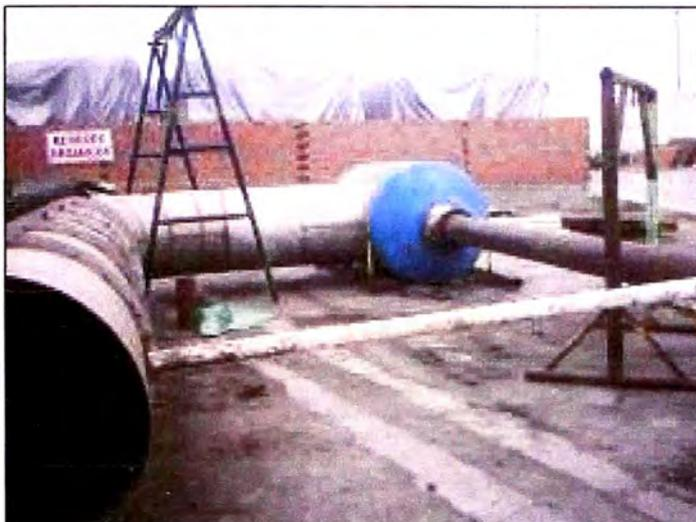
Figura 40 Instalación de ductos de condensador
