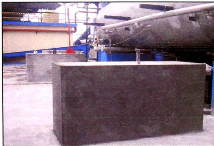
Figura 15 Base de secador rotadisk
