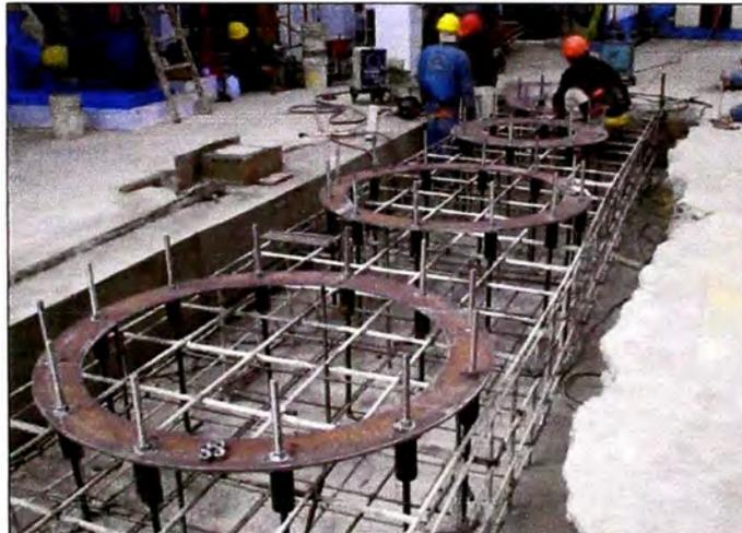
Figura 32 Estructura de base de efectos
