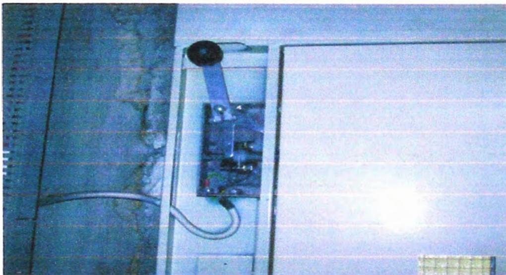
*Dibujo 5.11 Vista de la cerradura electromecánica instalada en el marco de la puerta de piso de un elevador*
