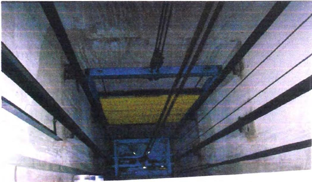
*Dibujo 5.2 Panorámica del pozo de un elevador se observa la suspensión cabina y contrapeso*
