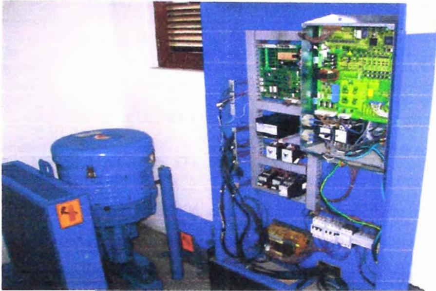
*Dibujo 5.17 Tablero de control de un elevador*
