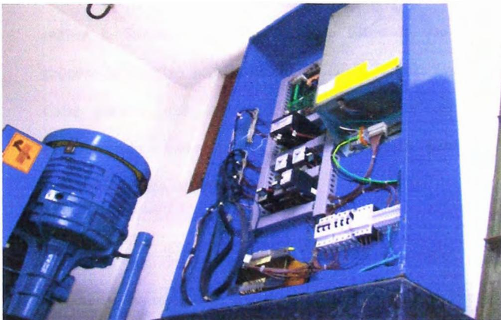
*Dibujo 3.4 Sala de máquinas de un elevador se observa el equipo motriz y el tablero de control*
