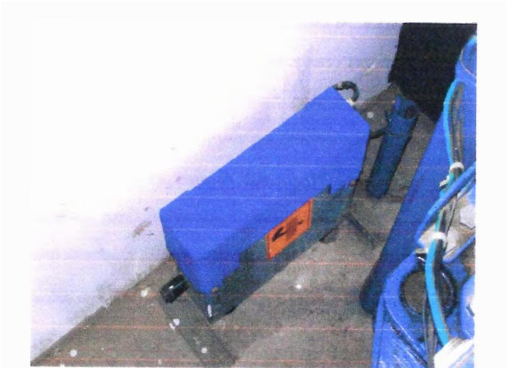
*Dibujo 5.15 Vista del limitador de velocidad en sala de máquinas*
