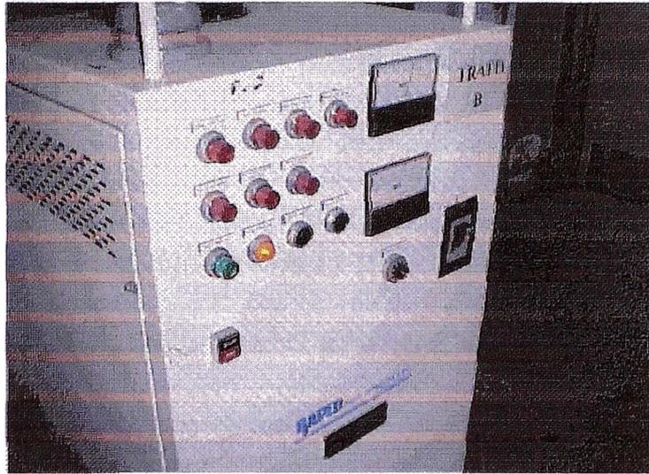
Fig. 2.10 Rectificador de corriente continúa.
