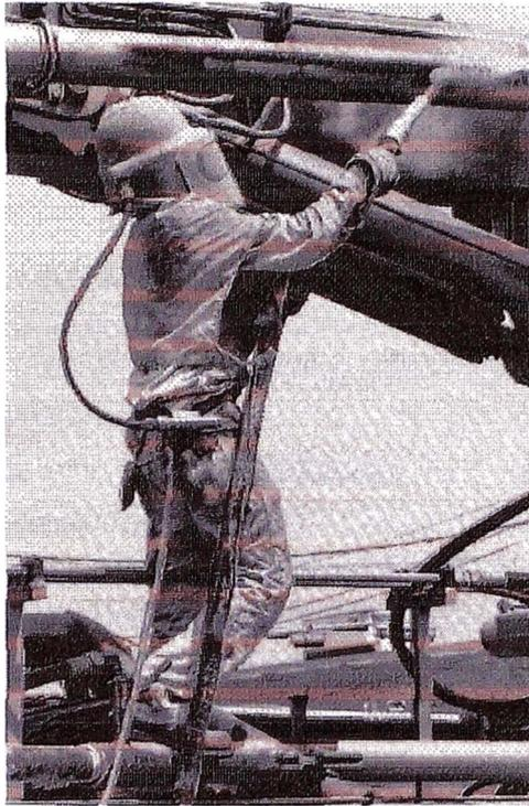
Fig. 2.2 Arenado comercial de estructura
