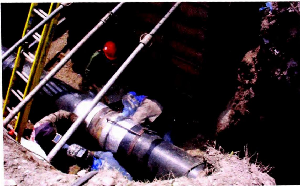
Figura N° 9: Trabajos de Soldadura en zanja. Ejecución de un TIE IN
