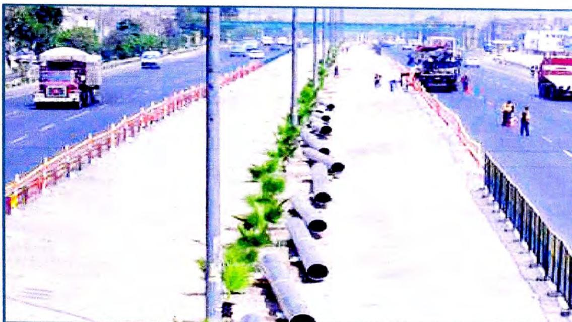
Figura N° 6: Desfile de Tubería en Vía de Evitamiento
