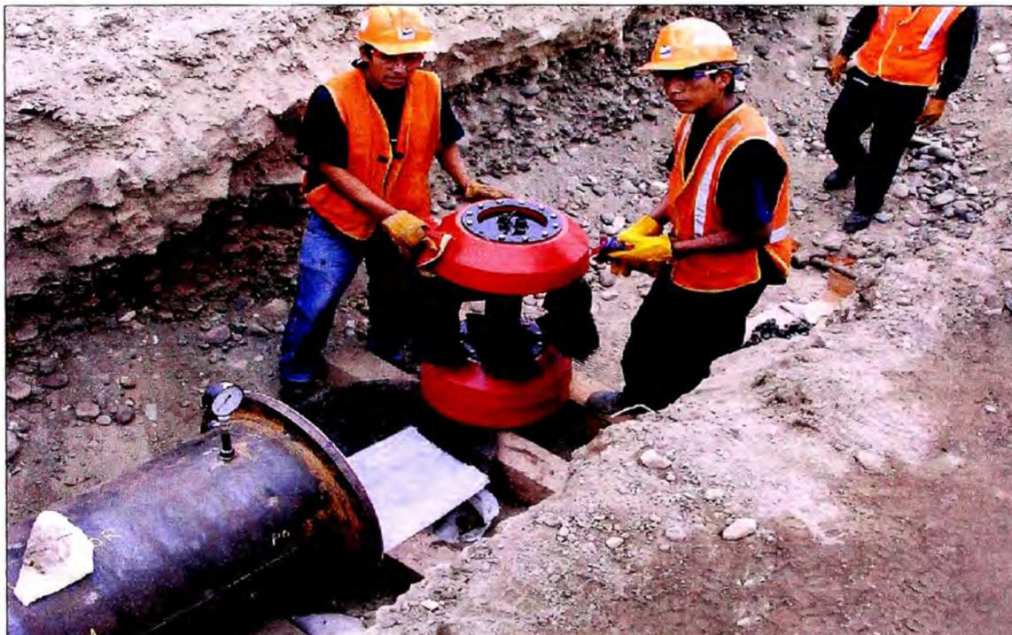
Figura N° 19: Instalación de Brushing Pig para prelimpieza de tubería
