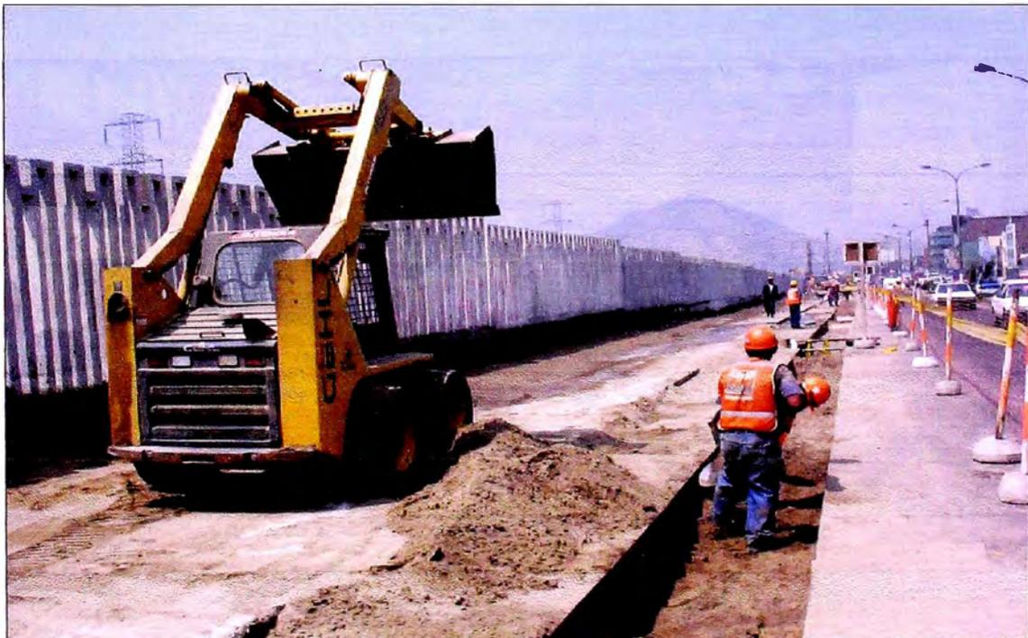
Figura N° 16: Relleno de Zanja
