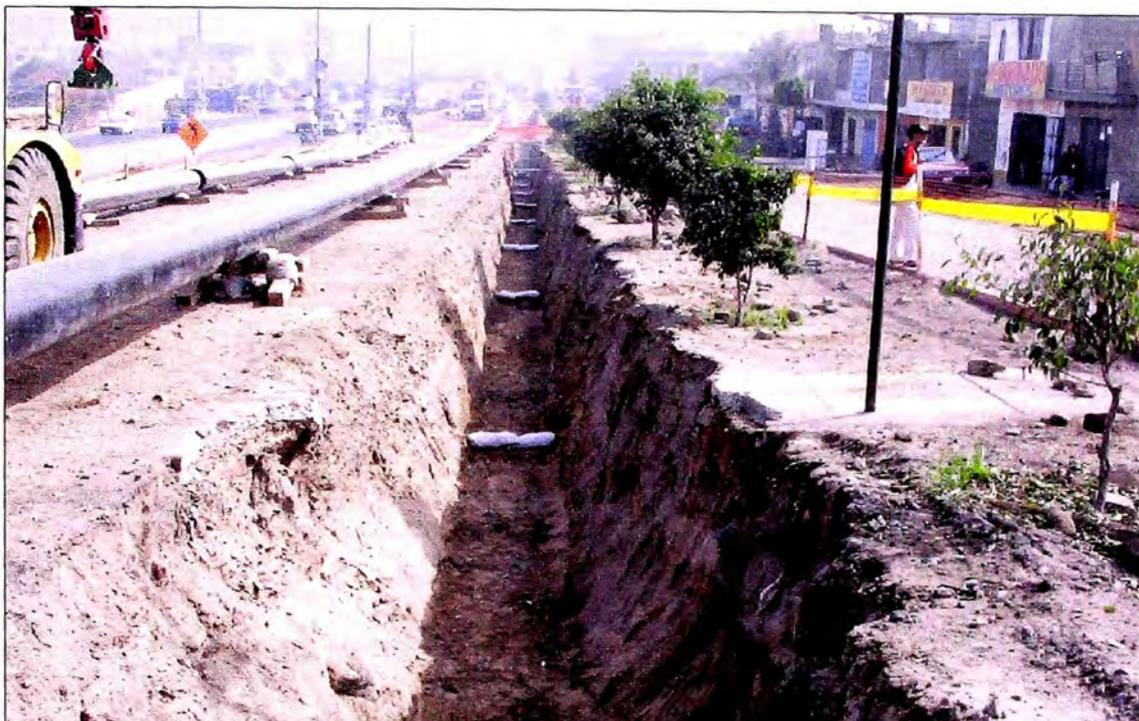
Figura N° 5: Zanja perfilada y preparada para la bajada de tubería
