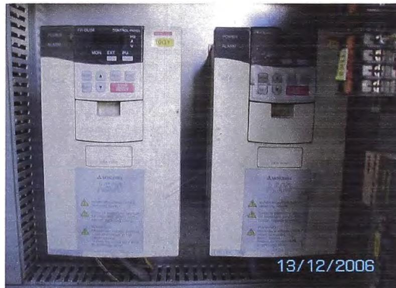
Figura 3.21 Variadores de velocidad dentro del Gabinete Eléctrico
