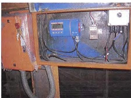
Figura 5.3 Tablero de Control de Bombeo de Acido [4]
