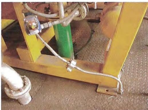
Figura 5.2 Instalación de Tubería de Acido y Anclaje del Filtro[4]
