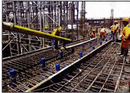
Figura N° 1.6.- Demora en instalación de bomba de concreto
