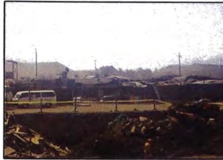
Figura N° 2.6.- Reducción de visibilidad en obra por vientos Paracas.
