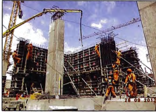
Figura N° 1.4.- Paralización de vaciado por levantamiento de observaciones
