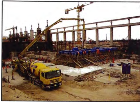
Figura N°3.1.- Ubicación de mixer en posición de descarga
