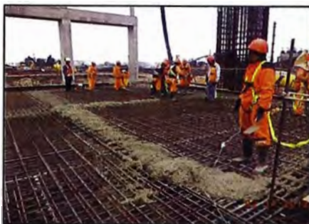
Figura N° 2.4.- Vaciado de losa maciza
