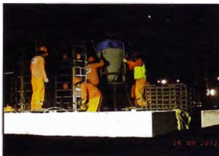
Figura N° 2.5.- Vaciado de pedestal
