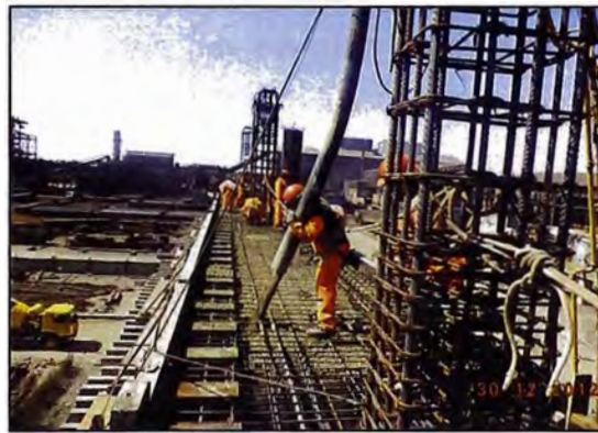
Figura N° 1.3.- Vaciado de concreto premezclado
