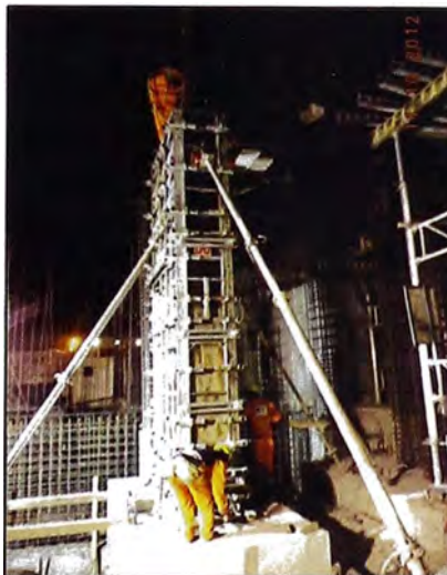
Figura N°3.2.- Descarga de concreto en elemento estructural
