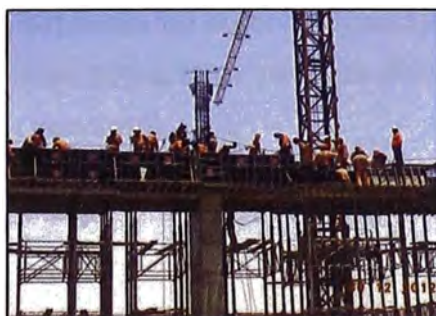
Figura N° 2.7.- Trabajos simultáneos de trabajadores del cliente y contratista
