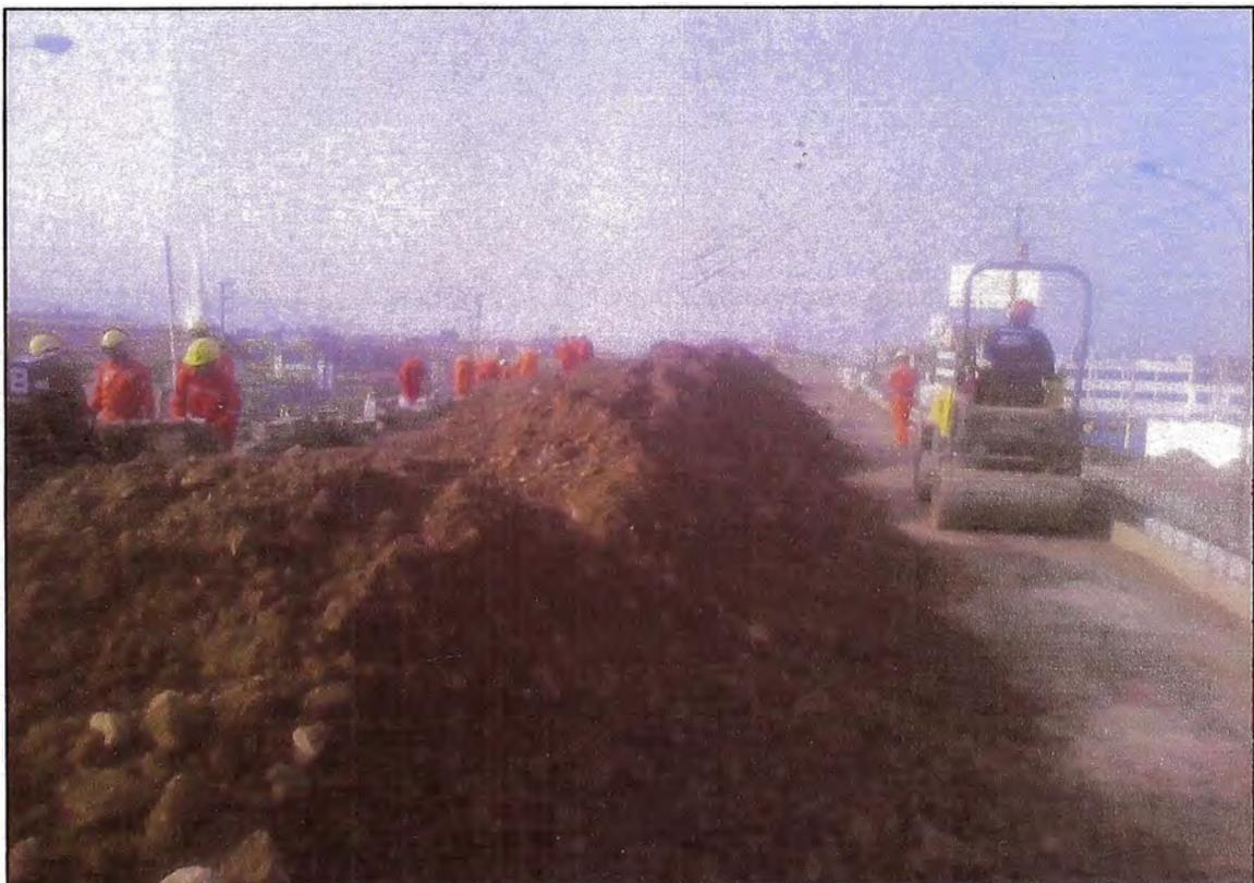
**Figura N°1.21.- Muro de suelo reforzado – Compactación con equipo mediano.**
