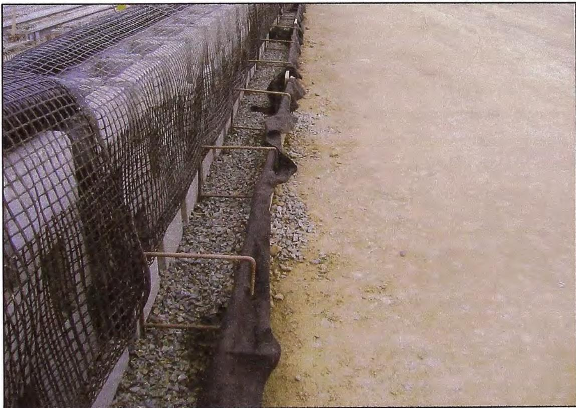
Figura N°1.24.- Muro de suelo reforzado – Colocación de Filtro y Geotextil.
