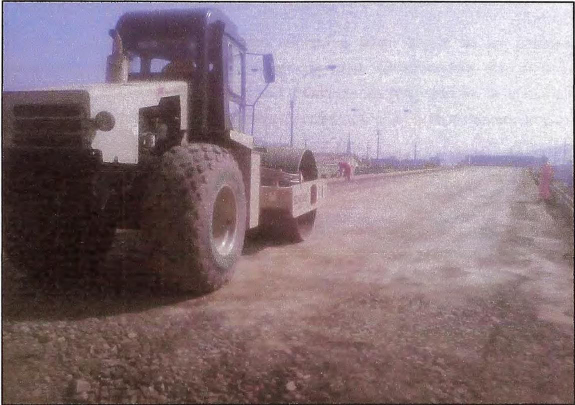
**Figura N°1.20.- Muro de suelo reforzado – Compactación con equipo pesado.**
