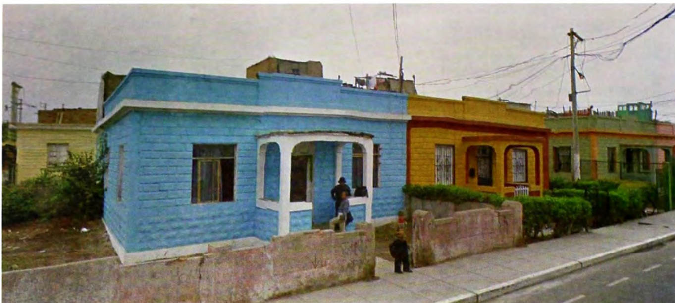
Figura 7. Casas para Empleados y Obreros, 1924.
