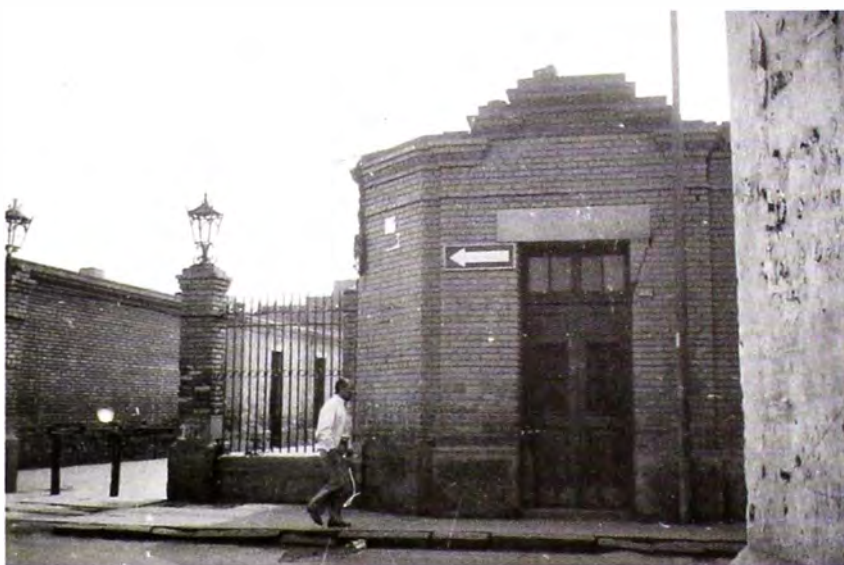
Figuras 9 y 10, Vistas exteriores de la Casa N° 1.
