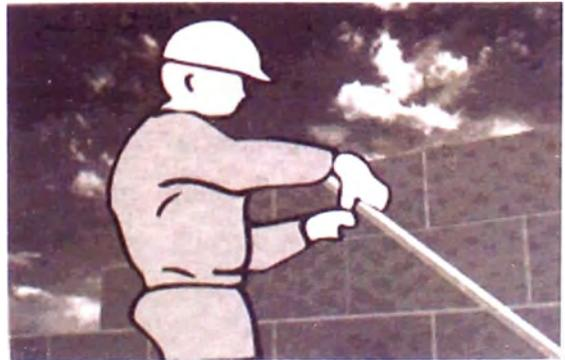
Las tuberías para las instalaciones eléctricas se pueden introducir en el interior de los muros, en celdas que no vayan a tener, a medida que avanza la elevación de éstos.
