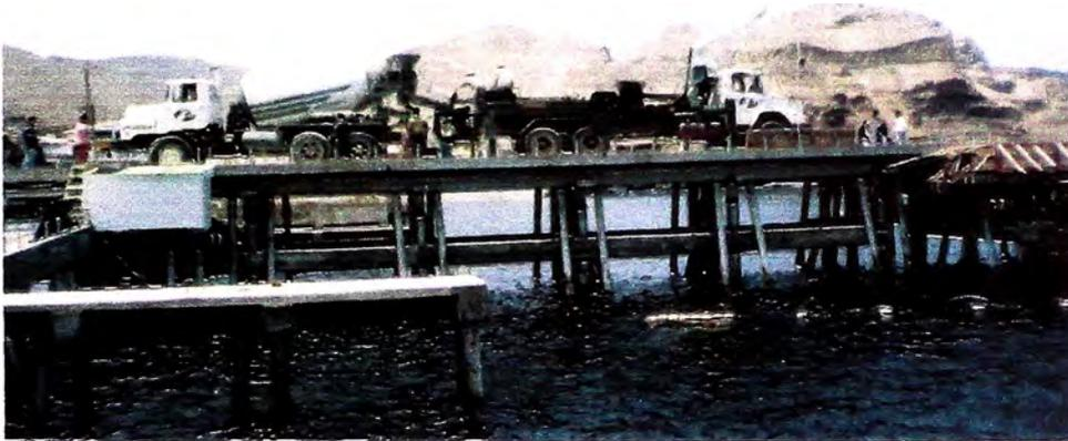
FOTO N° 18: Vista del Mixer vaciando el concreto.
