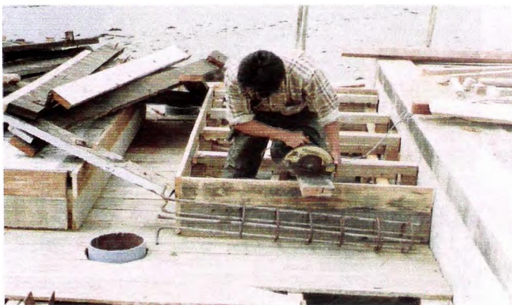
FOTO N° 34: Preparación de las barras de transmisión de esfuerzos.
