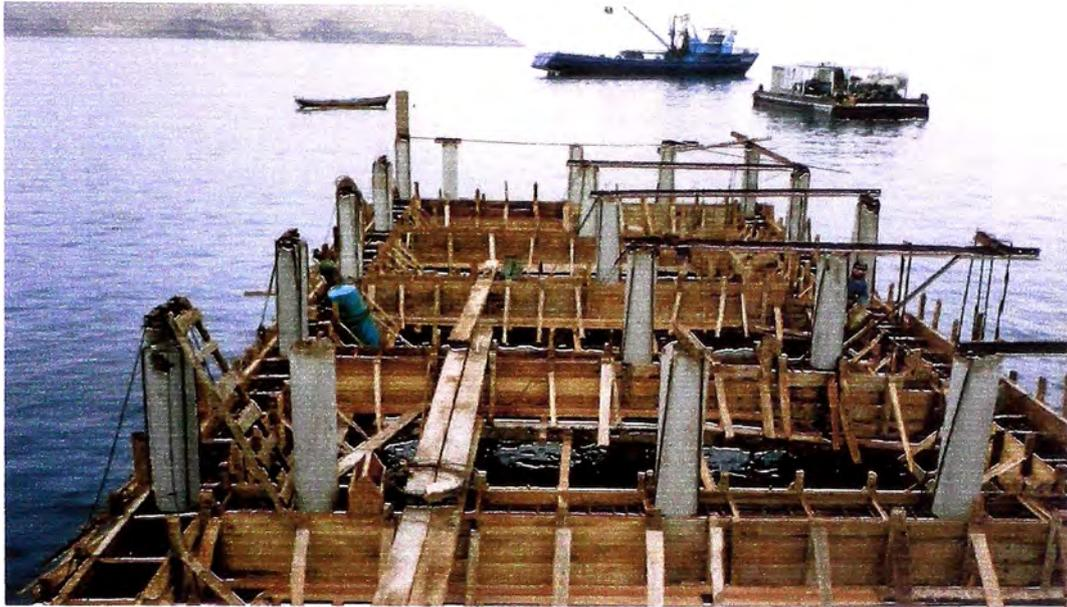
FOTO N° 40: Armado de las vigas de arriostre.
