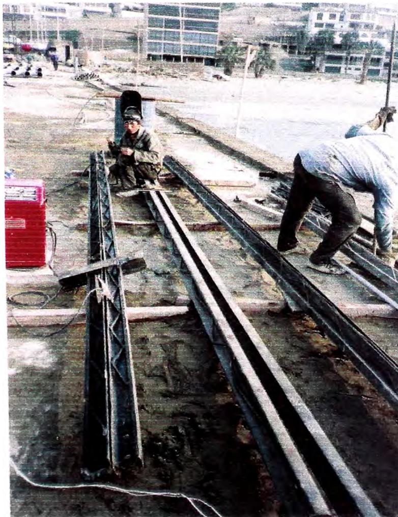
FOTO N° 22: Preparación del pilote tipo riel para su hincado.
