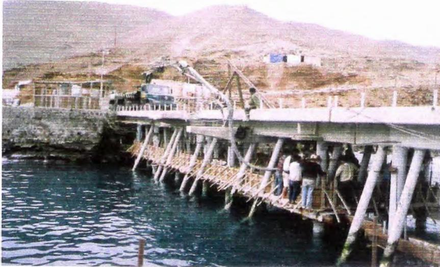
FOTO N° 48: Vaciado de concreto en las vigas de arriestre.
