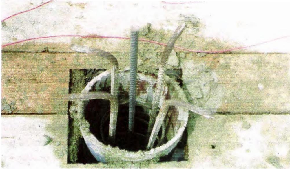
FOTO N° 35: Instalación de las barras de transmisión de esfuerzos.
