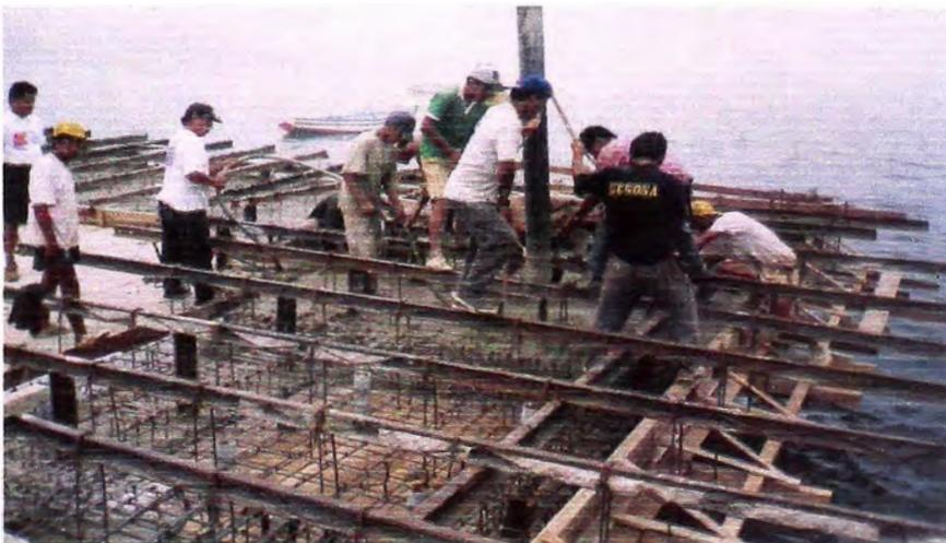
FOTO N° 50: Vaciado de concreto en vigas longitudinales, transversales y losa en la zona del cabezo del muelle.
