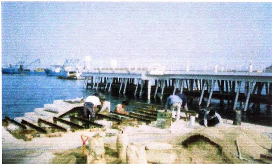
FOTO N° 42: Encofrado de los núcleos.
