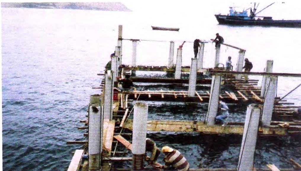
FOTO N° 39: Armado de las vigas de arriostre.
