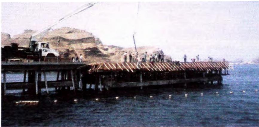
FOTO N° 49 Vaciado de concreto en vigas longitudinales, transversales y losa en la zona del cabezo del muelle
