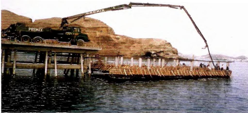
FOTO N° 51: Vaciado de concreto en las vigas de arriostre.
