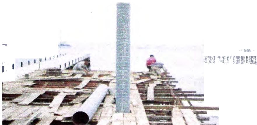
FOTO N° 28: Control de hinca mediante marcas cada 10.cm.
