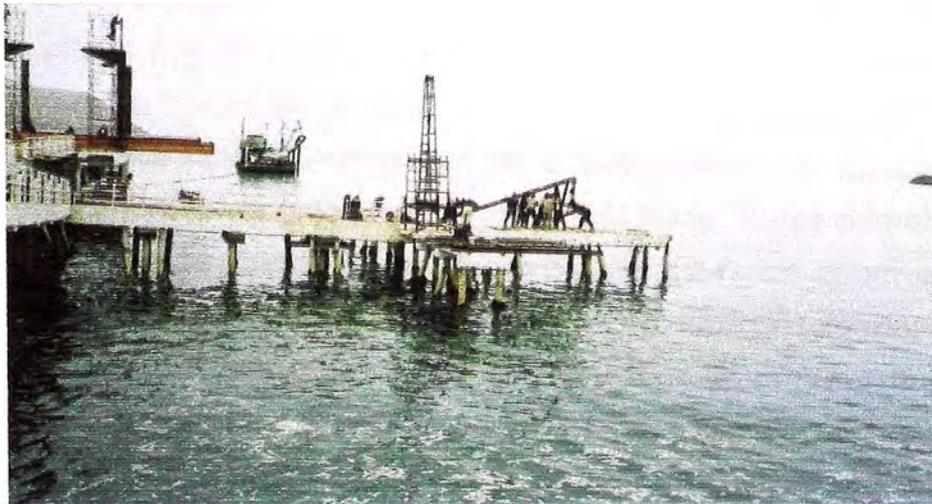
FOTO N° 26: Izado de pilotes inclinados.
