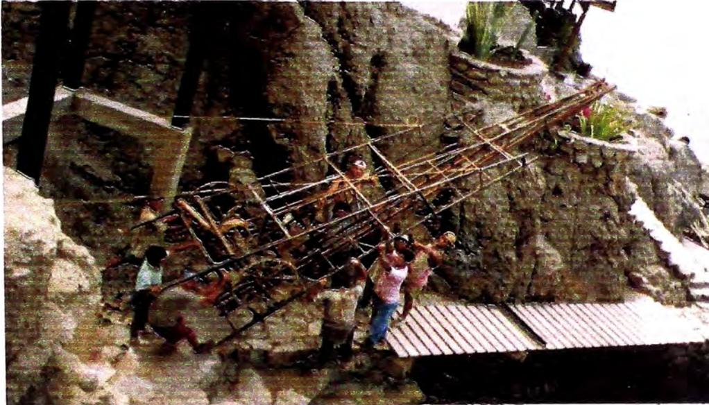
FOTO N° 12: Vista del traslado de un castillo de hincado.
