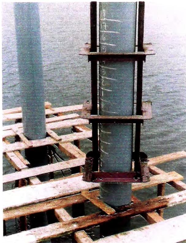
FOTO N° 23: Colocación de la guía de hincado en el pilote.
