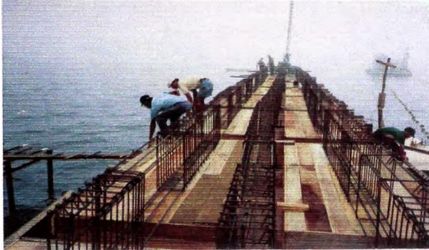
FOTO N° 44: Colocación de acero en las vigas longitudinales.
