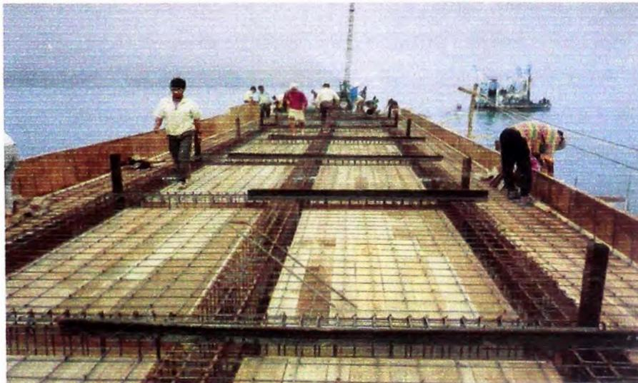
FOTO N° 45: Colocación de acero en las vigas longitudinales, transversales y losa.
