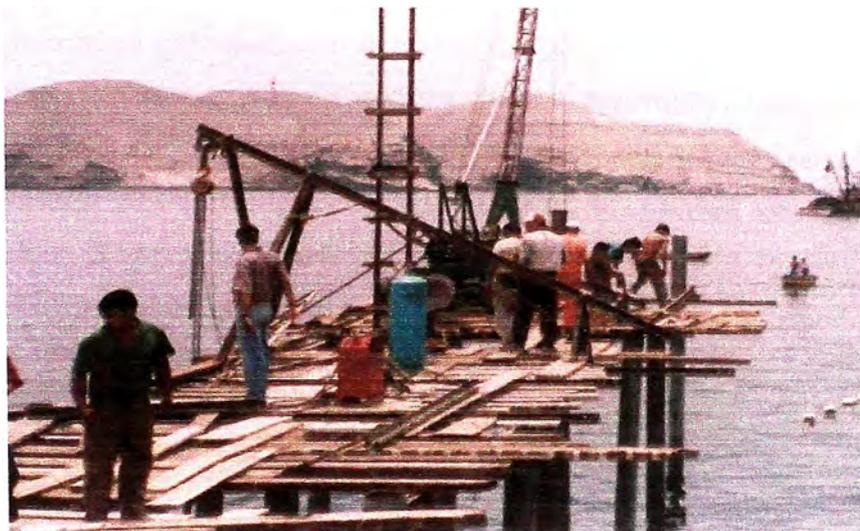
FOTO N° 20: Construcción del falso Puente.
