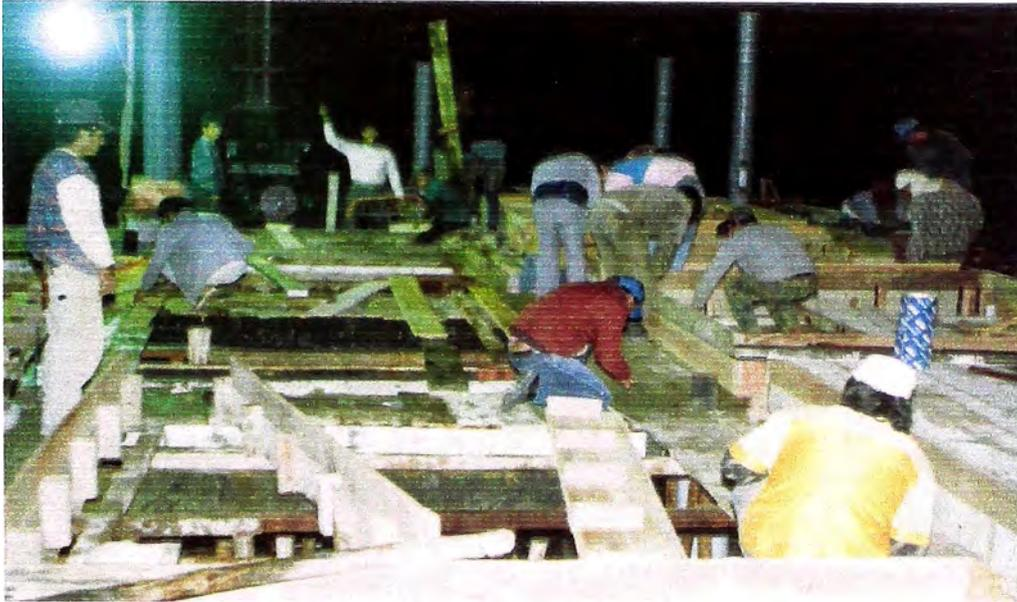
FOTO N° 38: Colocación del encofrado de losas.
