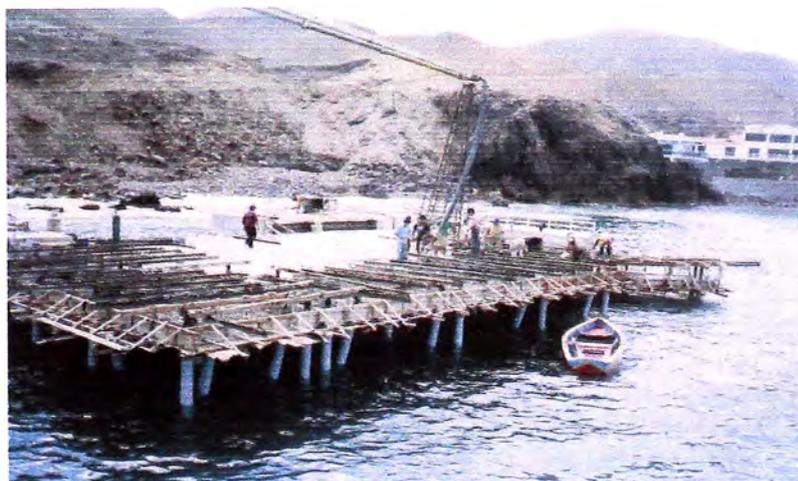
FOTO N° 47: Vaciado de concreto en las losa de la plataforma de servicios
