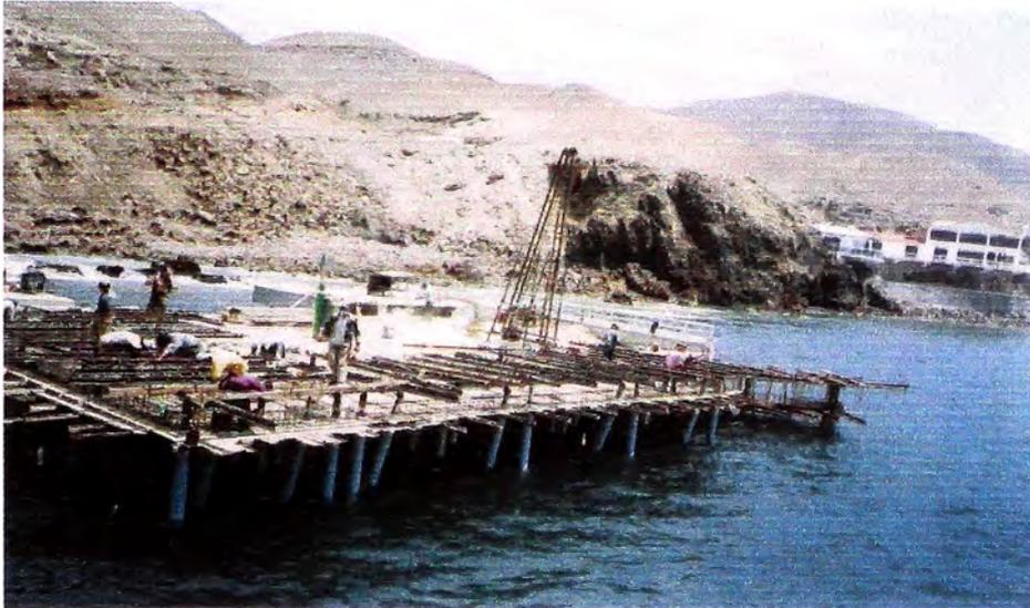
FOTO N° 46: Colocación de acero en la losa.
