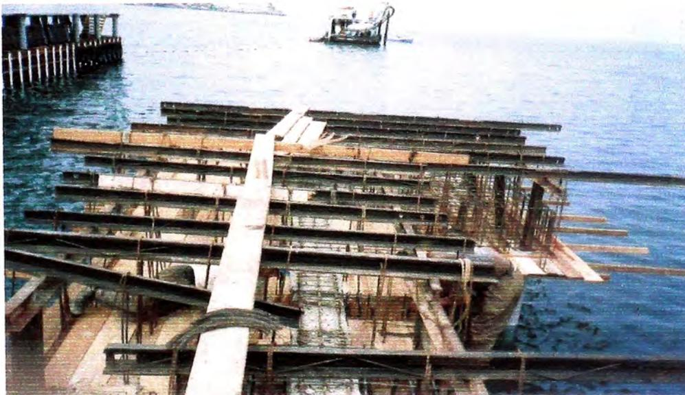
FOTO N° 37: Colocación de rieles tipo "H" que servirán para soportar el peso del encofrado, acero y concreto fresco al momento del vaciado.
