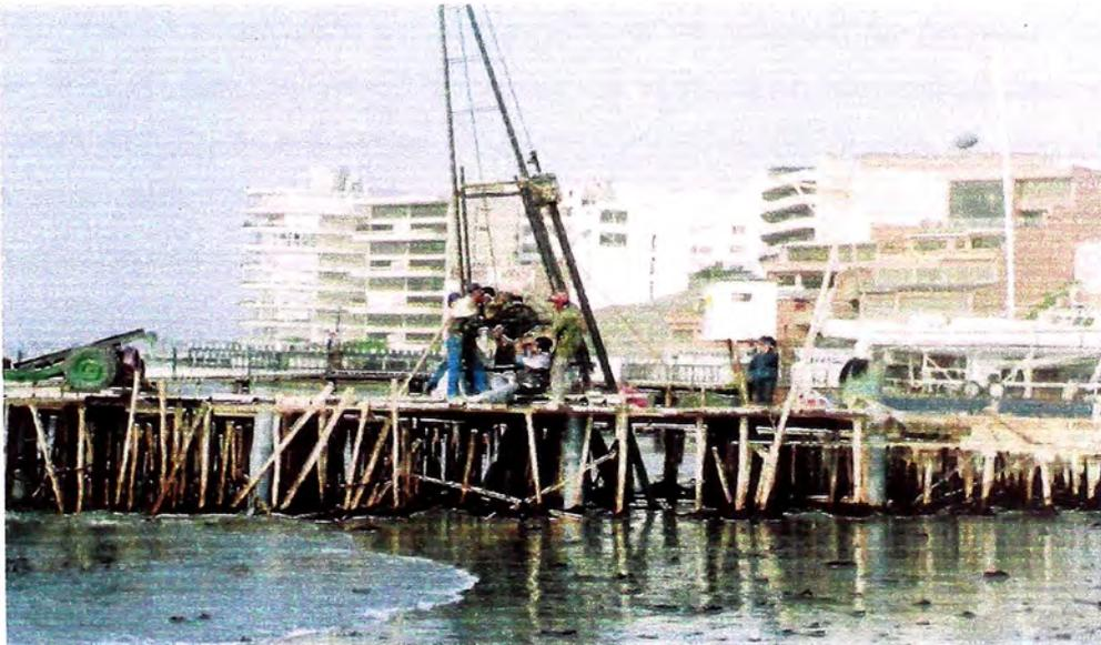
FOTO N° 29: Hincado de pilotes inclinados.
