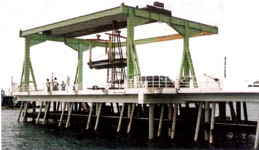
FOTO N° 57: Montaje de grúa puente.
