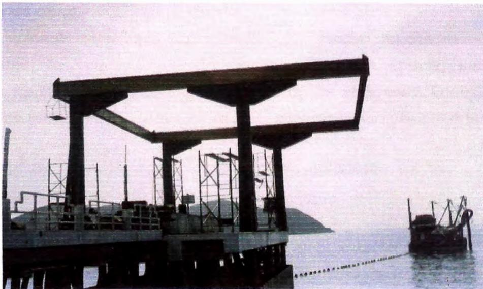
FOTO N° 59: Montaje de grúa puente
