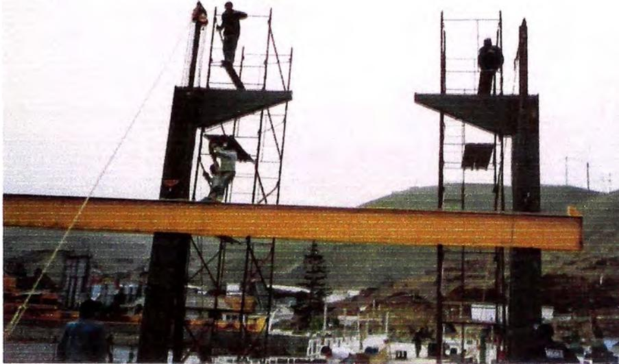
FOTO N° 56: Montaje de la viga puente.
