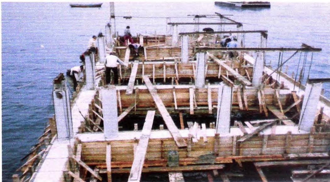
FOTO N° 52: Terminado de vaciar en las vigas de arriostre.
