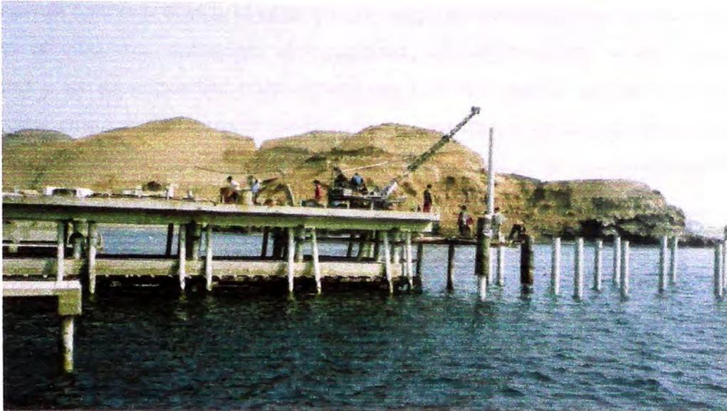
FOTO N° 33: Izado de las fundas de tubo PVC.
