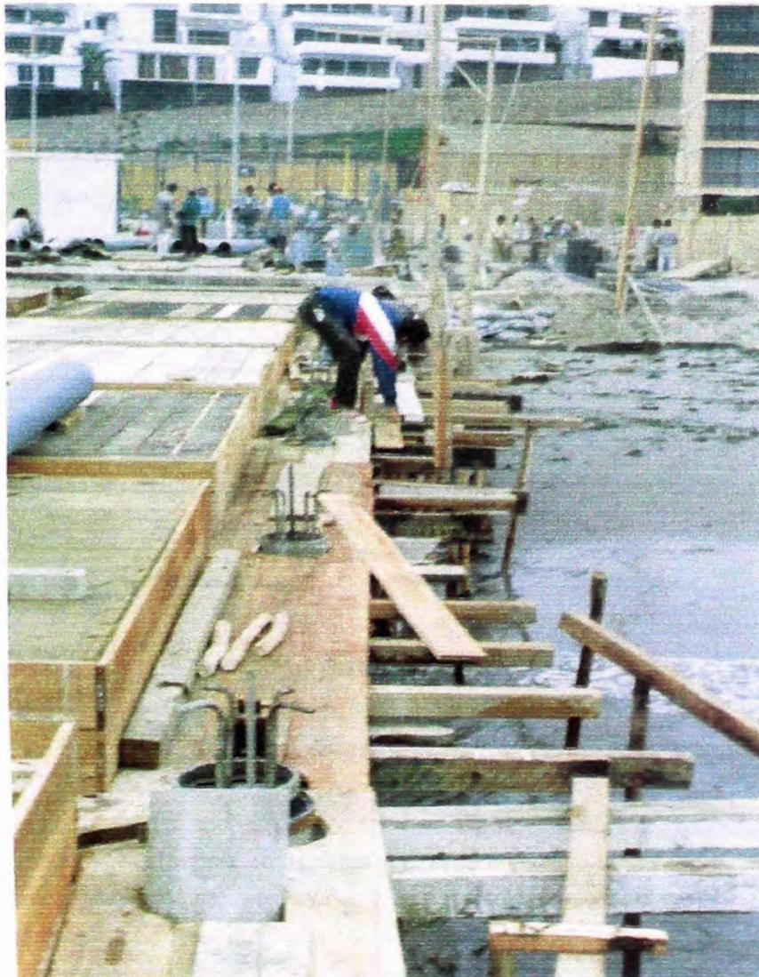
FOTO N° 36: Instalación de las barras de transmisión de esfuerzos.
