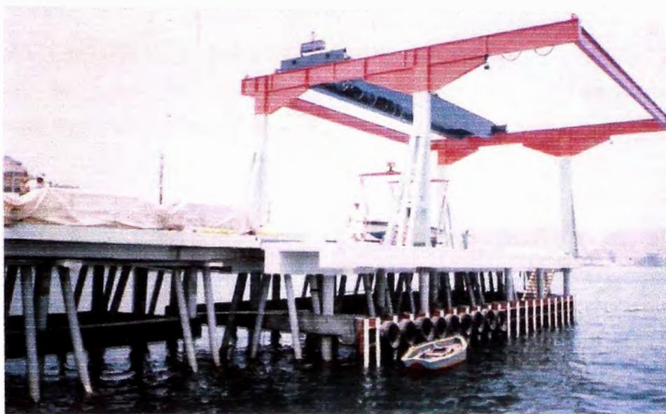
FOTO N° 58: Montaje de grúa puente.
