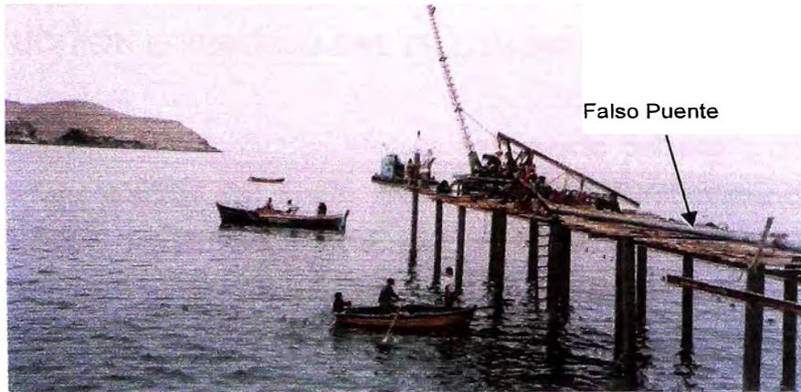
FOTO N° 19: Construcción del falso puente
