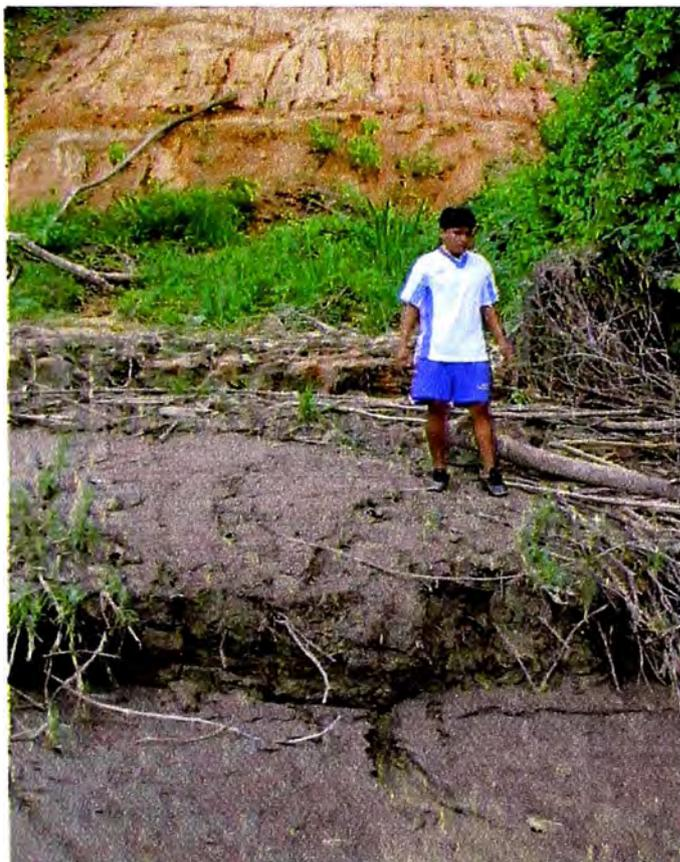
Figura 1-2: Detalle del contraste entre el material del escarpe de la terraza alta de la margen derecha (tonalidad rojiza) y los sedimentos aluviales recientes en la parte inferior (color gris), fotografía tomada en la orilla derecha y ligeramente aguas abajo del eje del puente.
