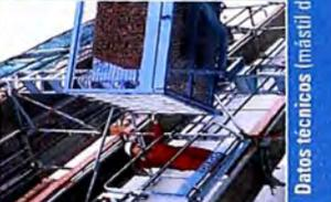
Los montacargas a cremallera con mástil de aluminio se llevan utilizando en zonas de obra desde hace varios años. Son máquinas ideales para los trabajos de andamiaje modernos que ofrecen gran resistencia. Su sencillo montaje, el alto nivel de seguridad, su solidez, su cómodo manejo y fácil transporte puede transportarse en remolques, como algunos de las ventosas de los GEDA, montacargas a cremallera frente a los elevadores de cable.
