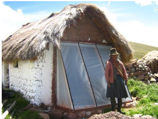
Figura N° 7. Aprovechamiento de la energía solar contra el friaje
