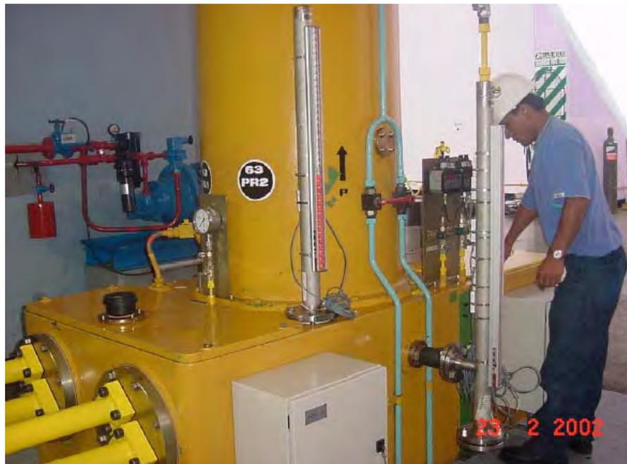
VISTA DE LOS SENSORES DE NIVEL DEL TANQUE Y ACUMULADOR
