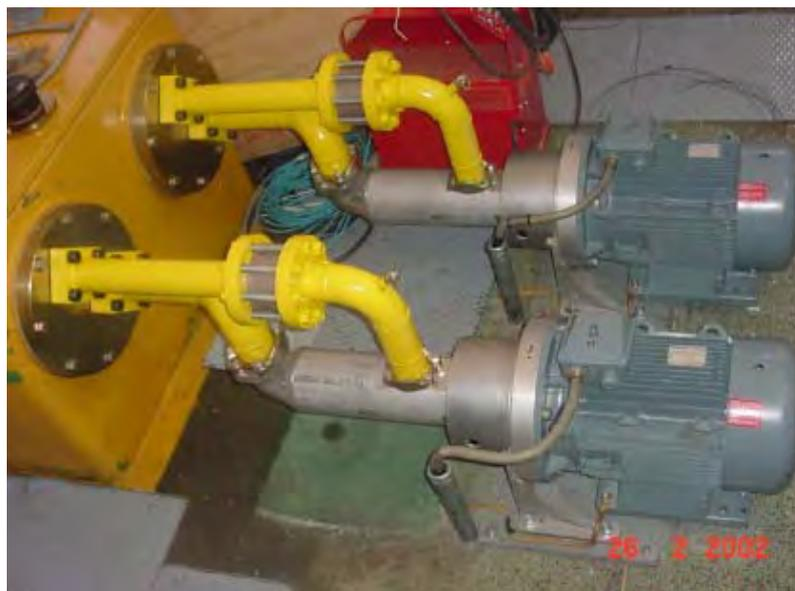
Figura 4.3 Conjunto motor – bomba de bombeo y acumulador de aceite
