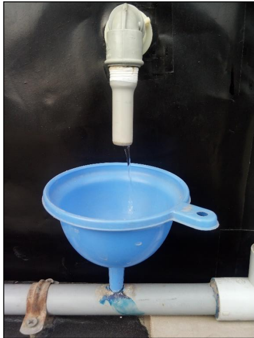
Figura 10.15. Salida del sedimentador y sistema de recolección conformado por un embudo y tuberías de PVC de Ø 1 pulg.
