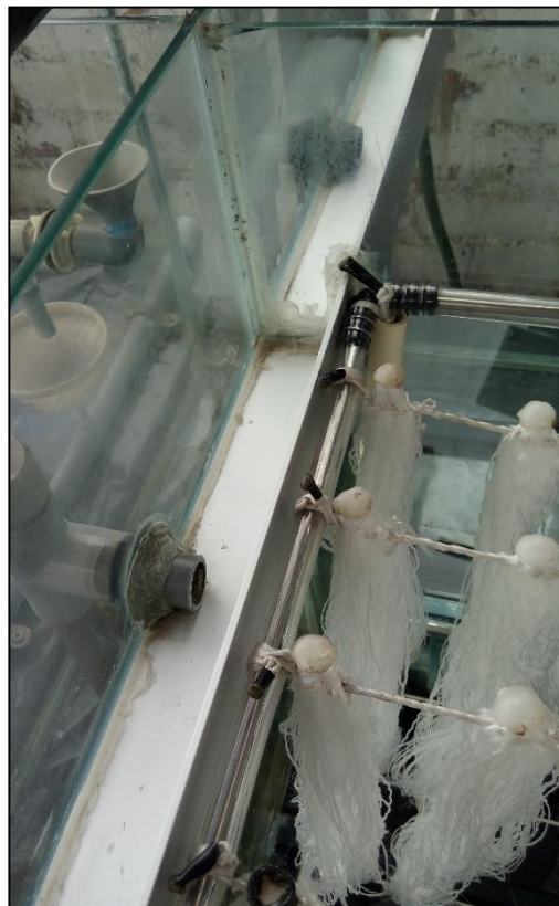
Figura 10.10. Vertedero de aluminio de 30 cm de largo por 5 cm de ancho y alto, además, se observa la tubería de PVC de paso hacia el decantador secundario.
