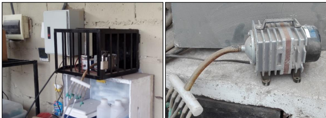
Figura 10.13. La imagen de la derecha muestra el compresor de aire marca ACO de 60 L/min, y la imagen de la izquierda muestra la canastilla donde se ubicó.
