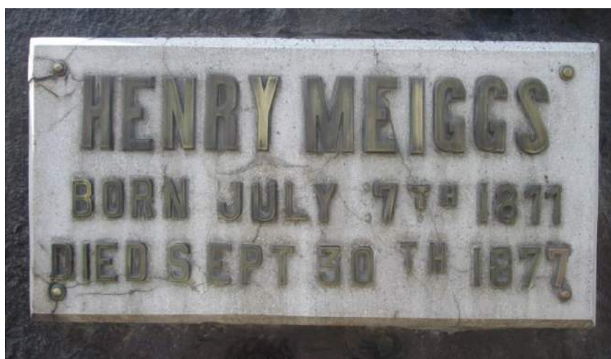
Figura 168. Tinción de la roca por contacto con pigmentos usados sobre el metal. Foto: Alexandra Gambetta, 2017.
