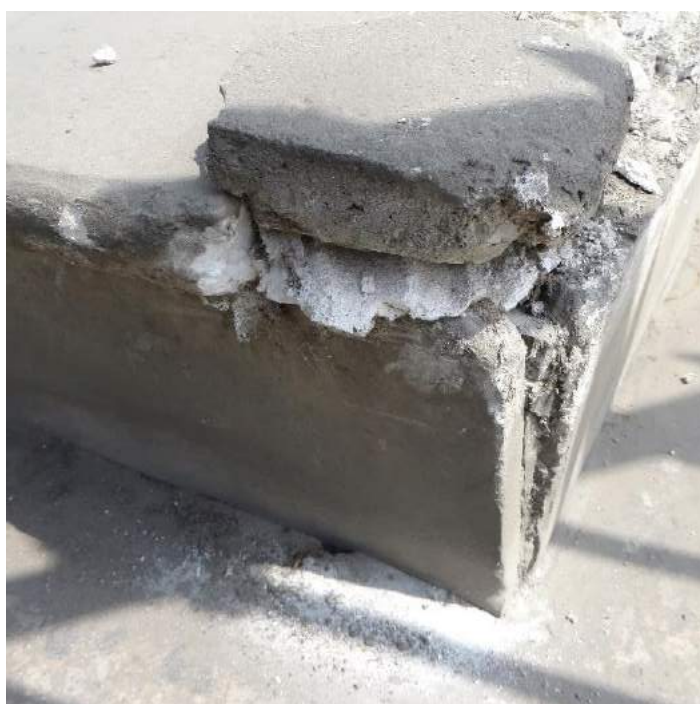
Figura 160. Disgregación sacaroida en la tumba de Ramón Castilla. Foto: Alexandra Gambetta, 2021.
