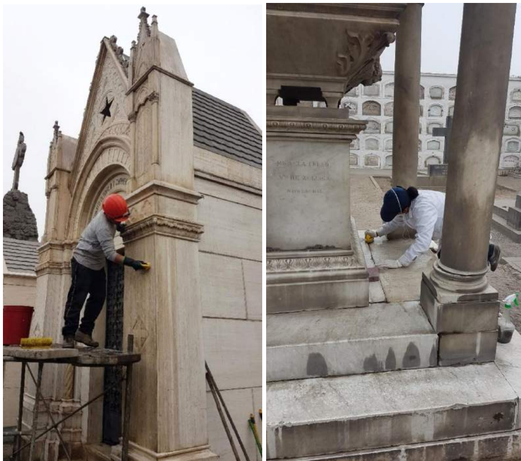
Figura 172. Proceso de limpieza superficial de tumbas frente a la reja de la Puerta 4. Fotos: Alexandra Gambetta, 2017.
