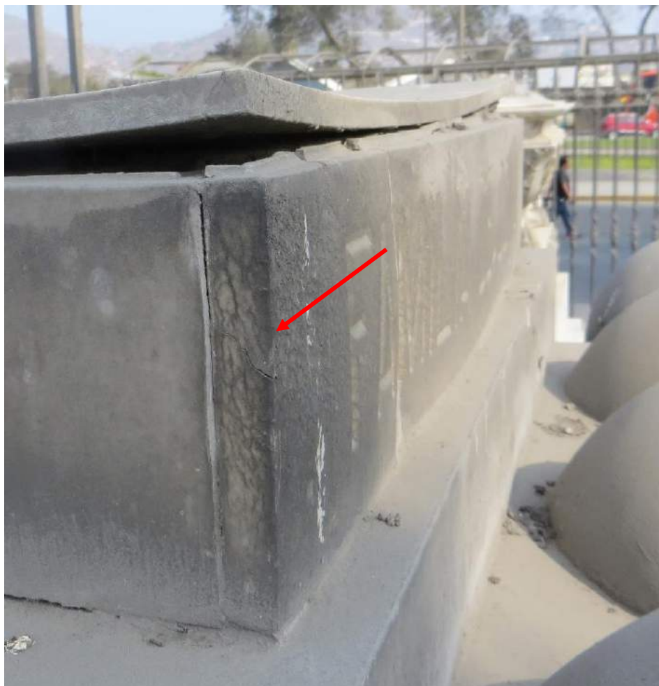
Figura 161. Microkarstificación en la tumba de la Familia de Osma. Foto: Alexandra Gambetta, 2021.
