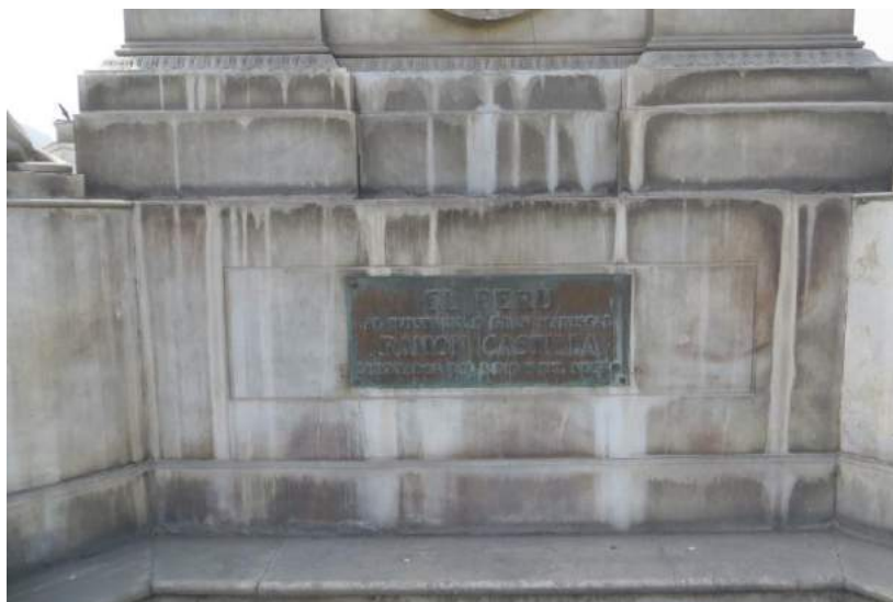
Figura 166. Blanqueamiento del mármol de cubierta en la tumba de Ramón Castilla. Foto: Alexandra Gambetta, 2021.
