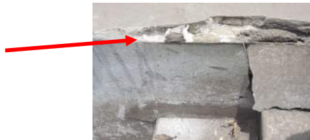
Detalle de disgregación sacaroida del mármol
