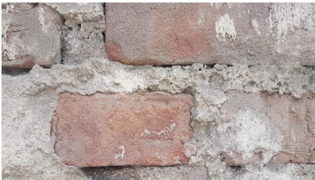
Figura 57. Detalle del material constructivo de los muros de nichos: ladrillo con mortero de arena y cal. Foto: Alexandra Gambetta, 2019.
