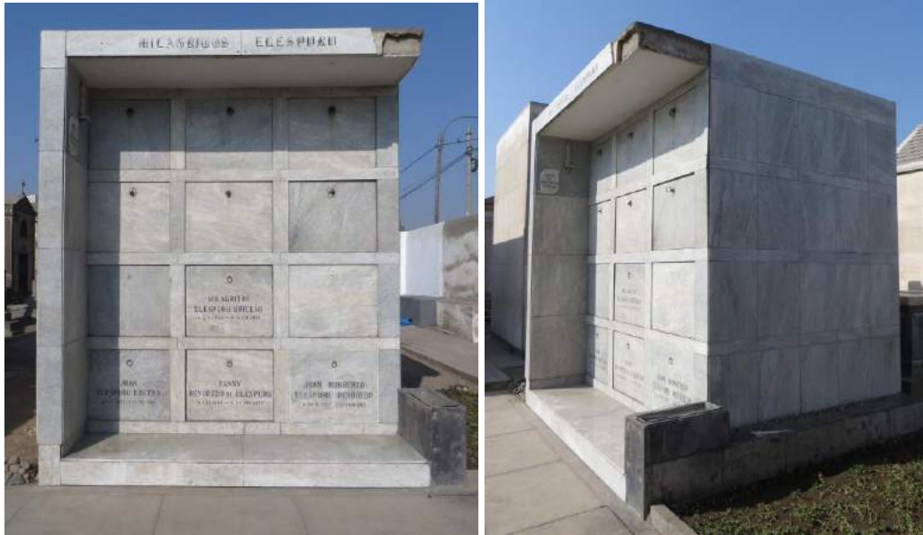
Figura 45. Construcción para gavetas y nichos de la familia Eléspuru (1977). Foto: Alexandra Gambetta, 2017.
