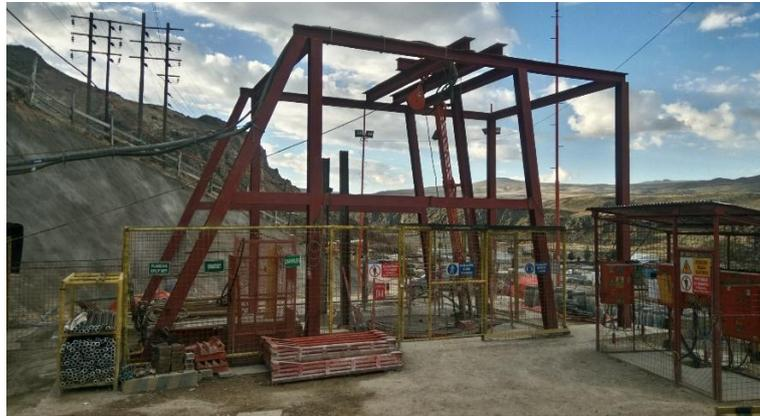
**Figura 2. 4** Montaje de Infraestructura para Equipo Raise Climber Descendente
