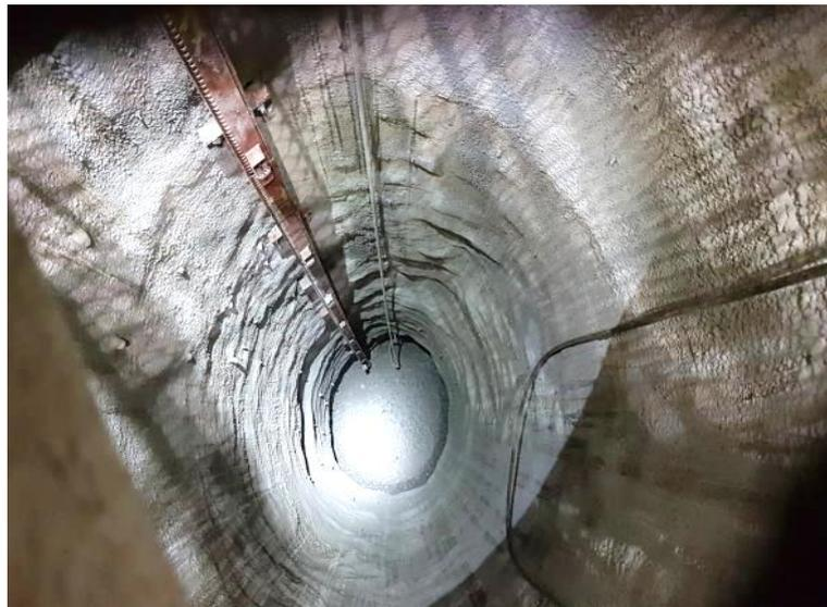
• **Figura 2. 1** *Revestimiento de Interior de chimenea Raise Boring*
