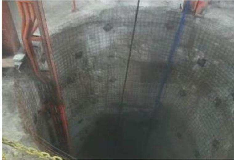
**Figura 2. 7 Anclaje de Carriles en Chimenea Raise Boring**
