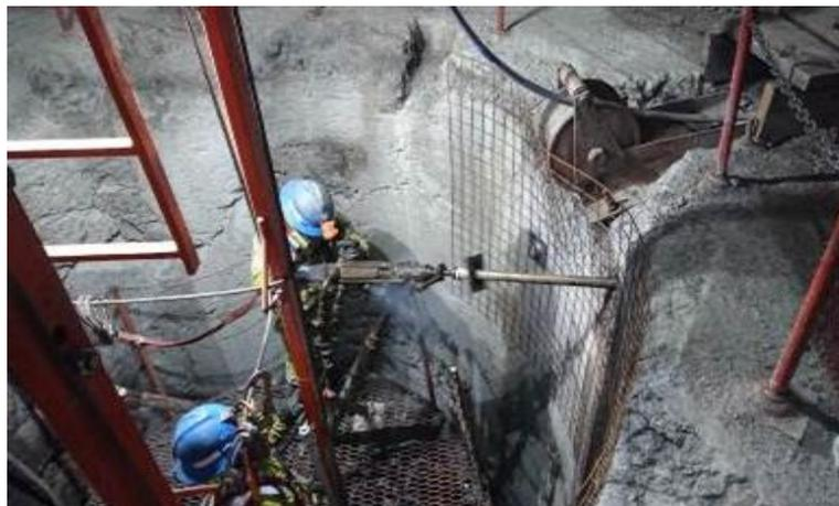
**Figura 2. 6** *Sostenimiento manual de chimenea Raise Boring*
