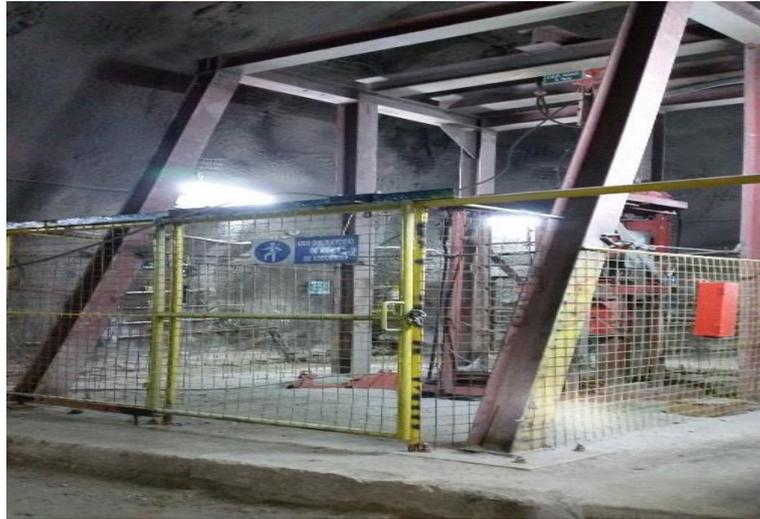
**Figura 2. 5** *Montaje de Vigas para instalación de Raise Climber en Interior Mina*
