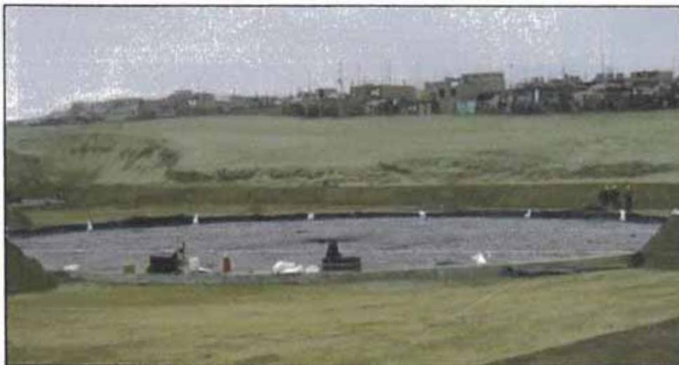
Fotografía N°07: Vista de los trabajos de impermeabilización con geosintéticos
