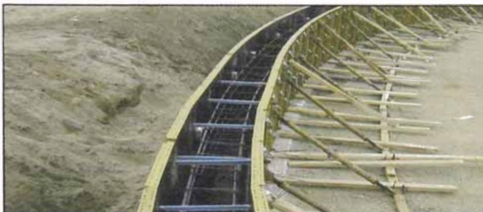
Fotografía N°02: Vista de una cimentación anular de tanque.
