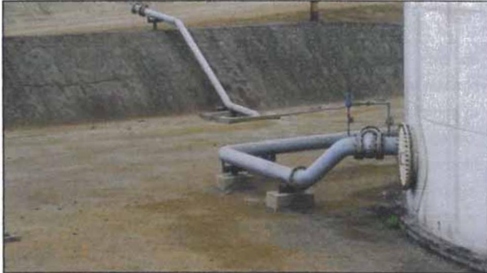
Fotografía N°06: Vista de soportes de tubería dentro del cubeto.
