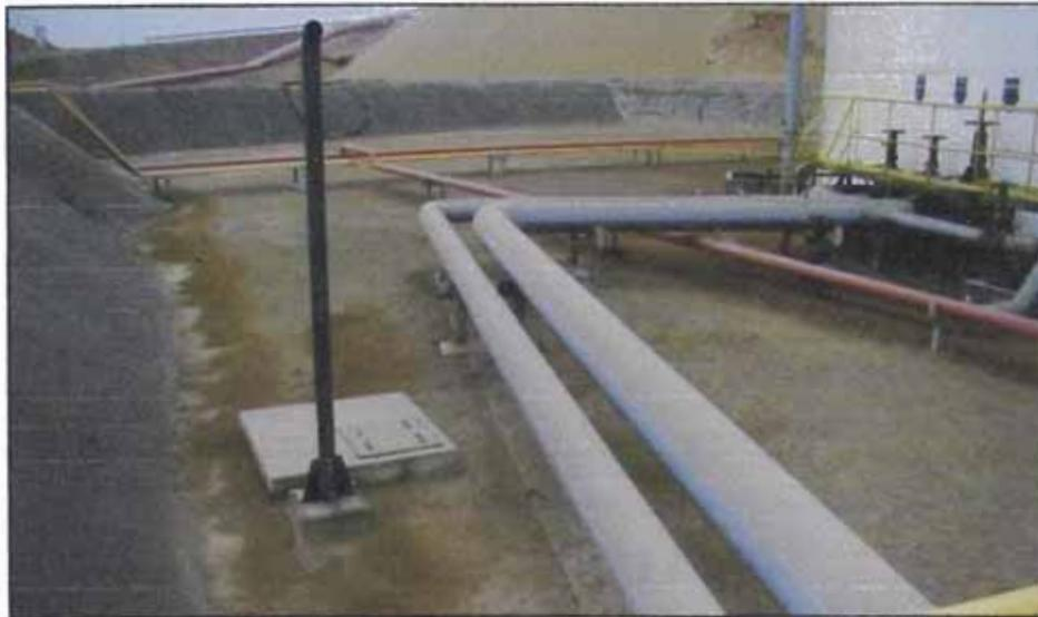
Fotografía N°05: Vista de buzones de drenaje dentro del cubeto.
